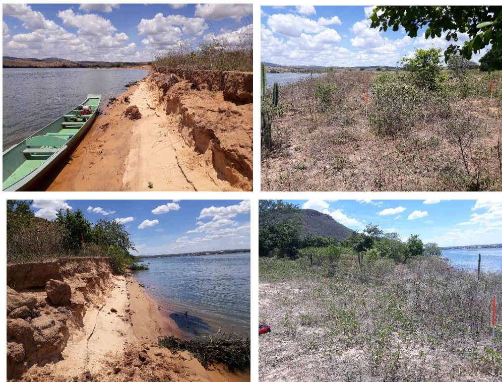
Figura 31 - EM B-06. Talude destituído de vegetação ao nível d'água em solo arenoso.
