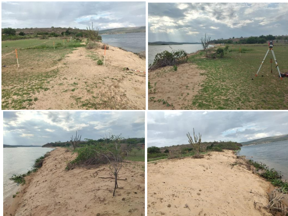
Figura 29 - EM B-05. Monitoramento Fotográfico de queda de barreira ao nível do N.A (Nível d'água).
