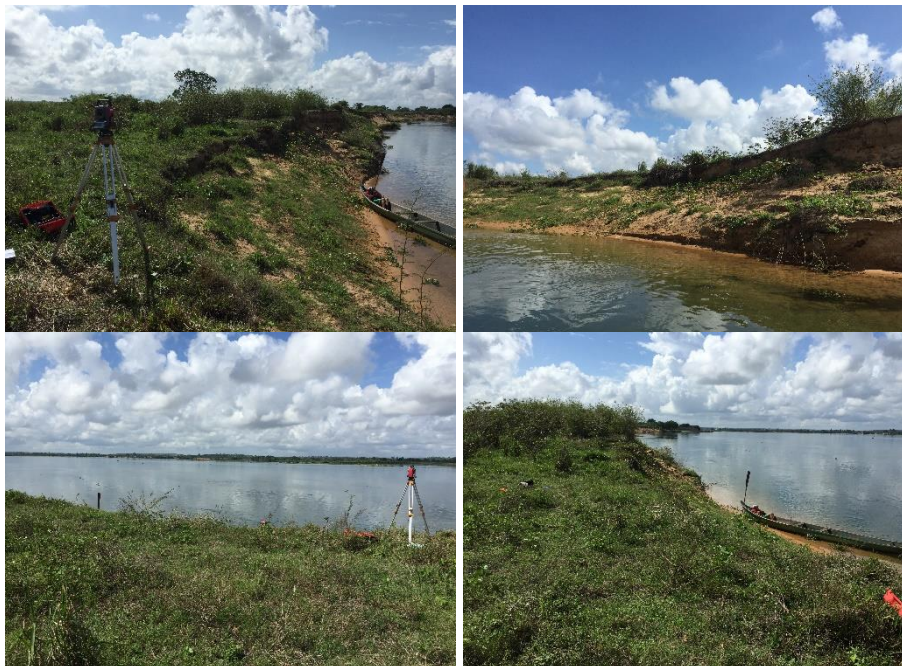
Figura 35 – Monitoramento Fotográfico da EM B-09. Talude destituído de vegetação ao nível d'água em solo arenoso.
