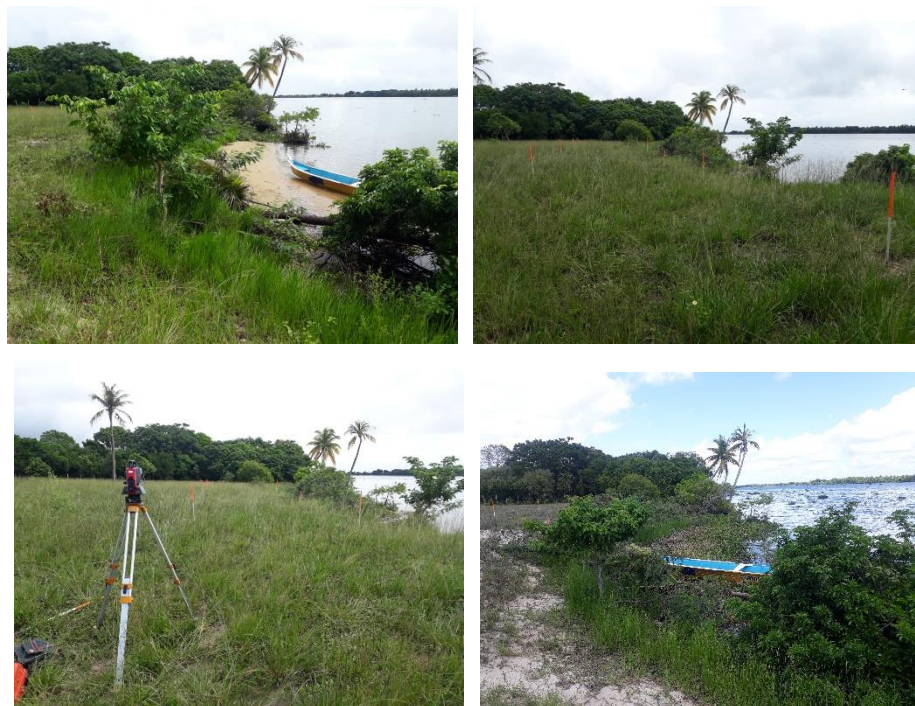
Figuras 27 - Visão do talude na EM 5.2, constituído por solo arenoso, vazante com influência da maré.
