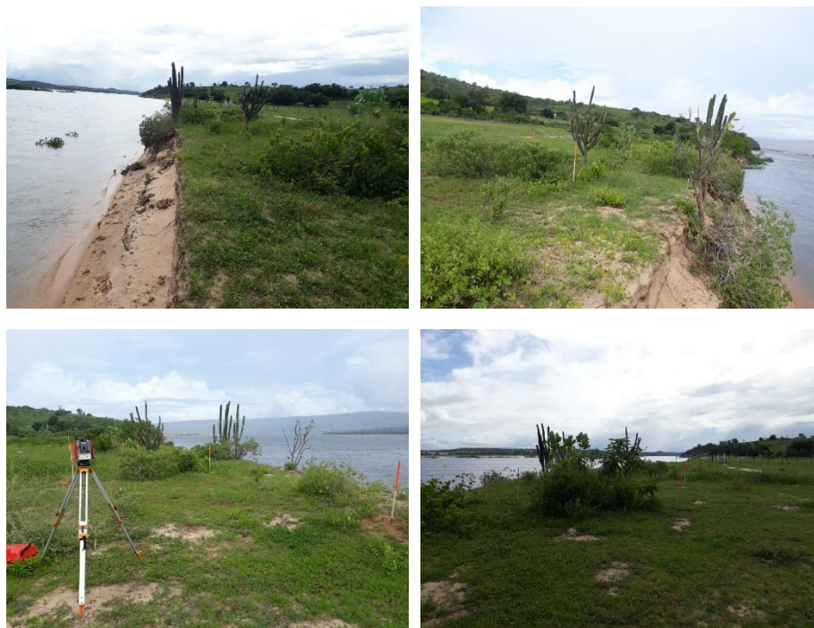
Figura 29 - EM B-05. Monitoramento Fotográfico de queda de barreira ao nível do N.A (Nível d'água).
