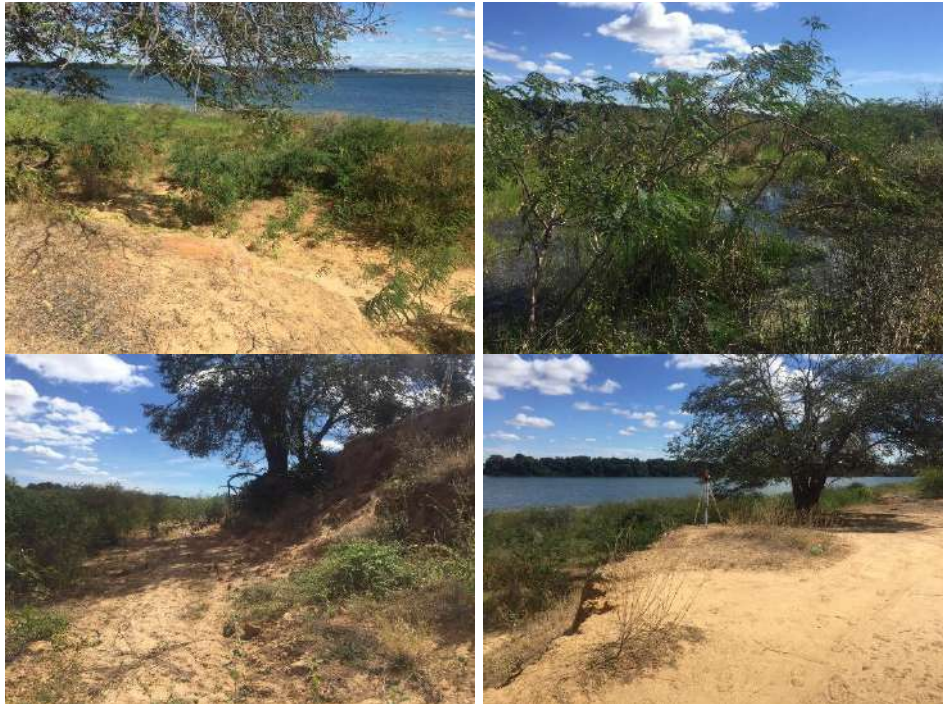
Figura 13 – Estação EM 1.1 com visão do coroamento barranco e nível do rio ocupado com vegetação arbustiva.
