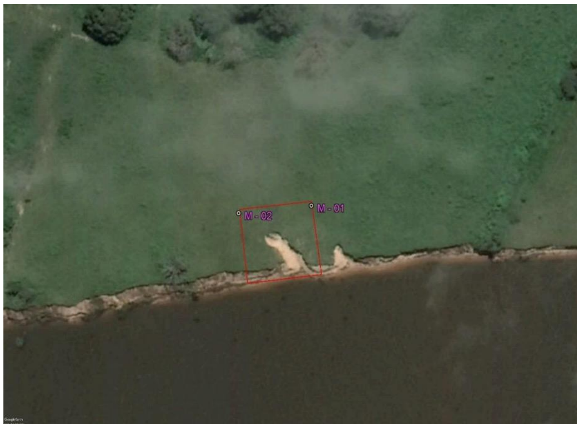
Figura 36 - Localização da Estação de Monitoramento EM B-10
