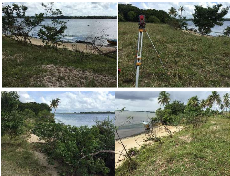
Figuras 27 – Visão do talude na EM 5.2, constituído por solo arenoso, vazante com influencia da maré
