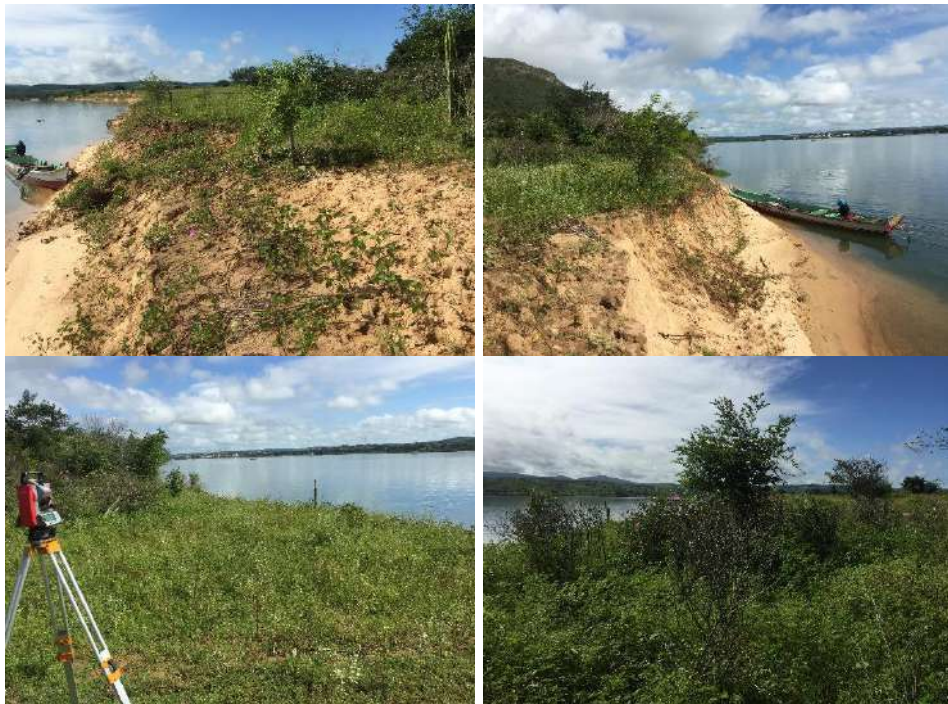
Figura 31 - EM B-06. Talude destituído de vegetação ao nível d'água em solo arenoso.
