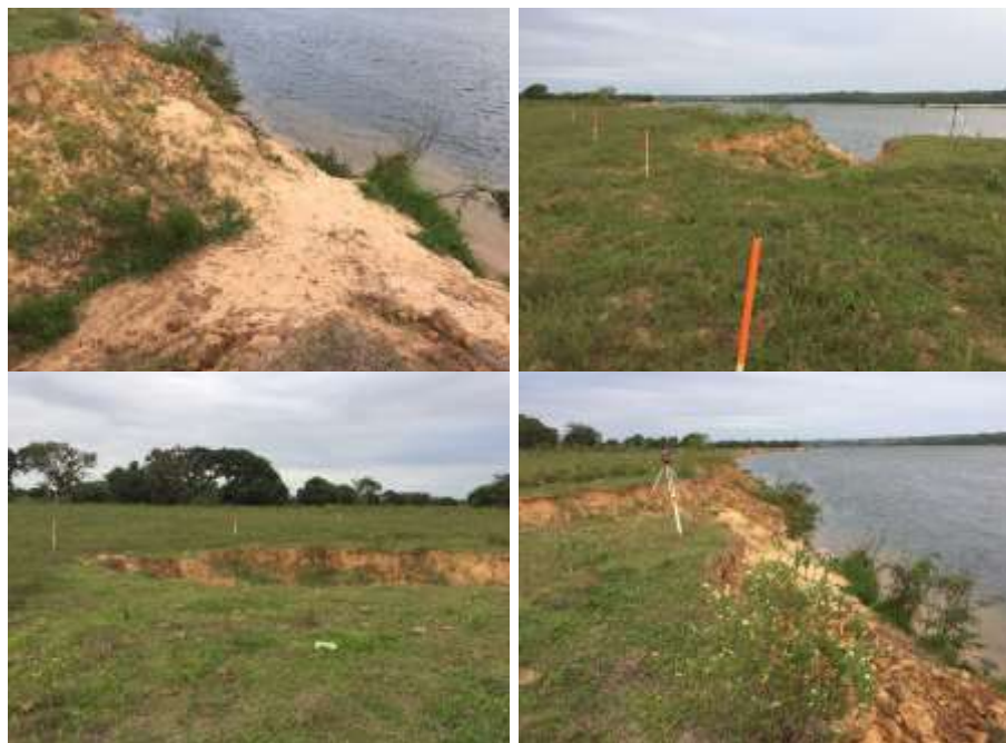
Figura 37 – Monitoramento Fotográfico da EM B-10 Talude destituído de vegetação ao nível d'água em solo arenoso.
