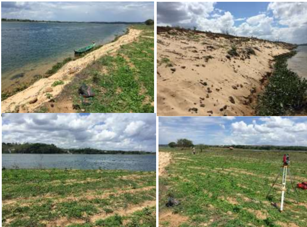
Figura 33 – Monitoramento Fotográfico da EM B-08. Talude destituído de vegetação ao nível d'água em solo arenoso.
