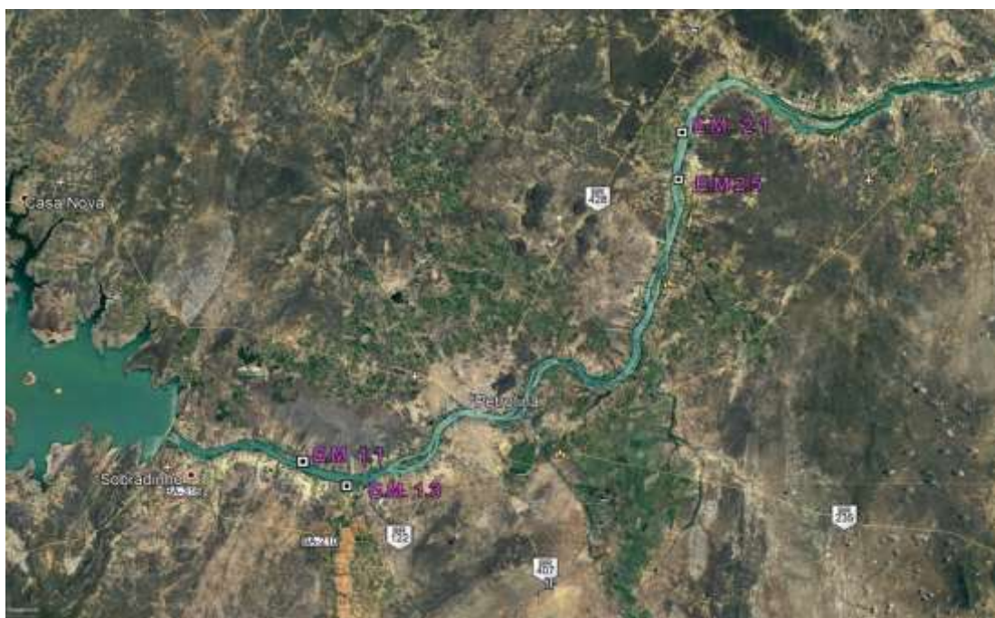
Figura 2 - Estações de monitoramento situadas à jusante da Barragem de Sobradinho. Margem esquerda: EM 1.1 e 2.1. Margem direita: EM 1.3 e 2.5
