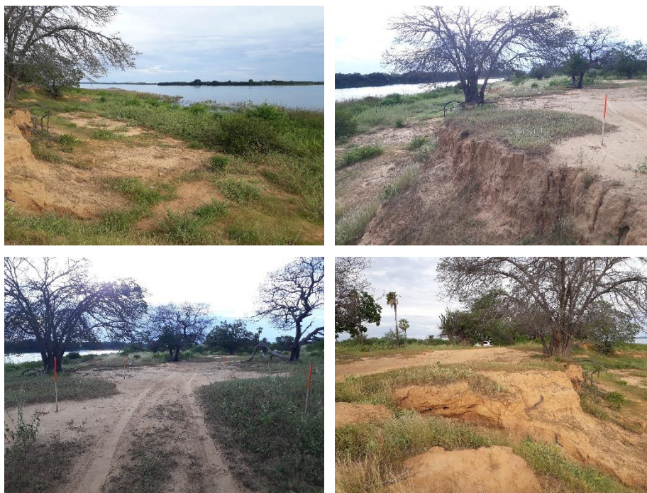
Figura 13 – Estação EM 1.1 com visão do coroamento barranco e nível do rio ocupado com vegetação arbustiva.
