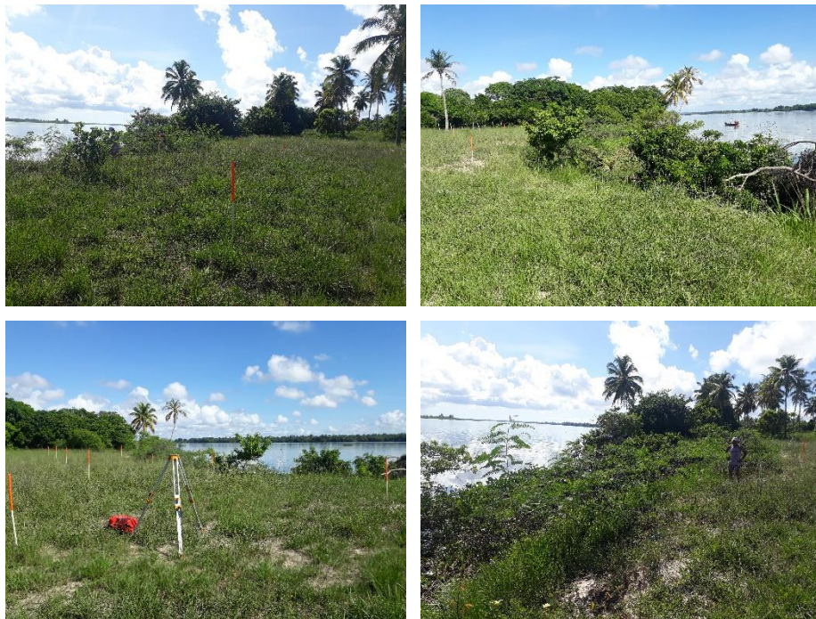
Figuras 27 - Visão do talude na EM 5.2, constituído por solo arenoso, vazante com influência da maré.
