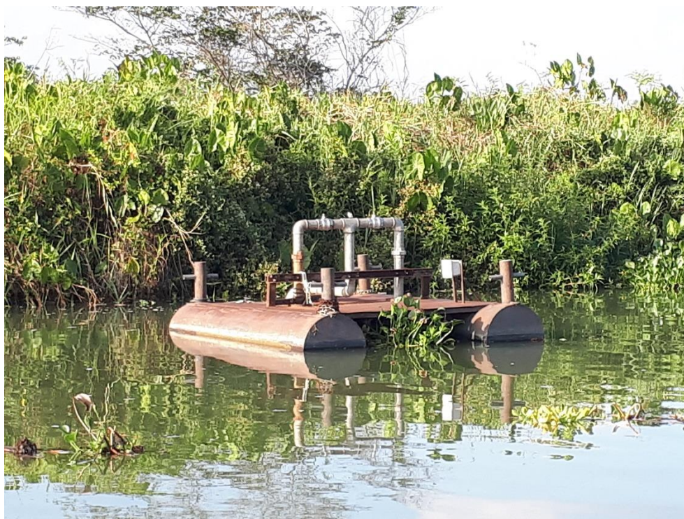
Figura 3: Bomba de captação de água da cidade de Brejo Grande - SE.
