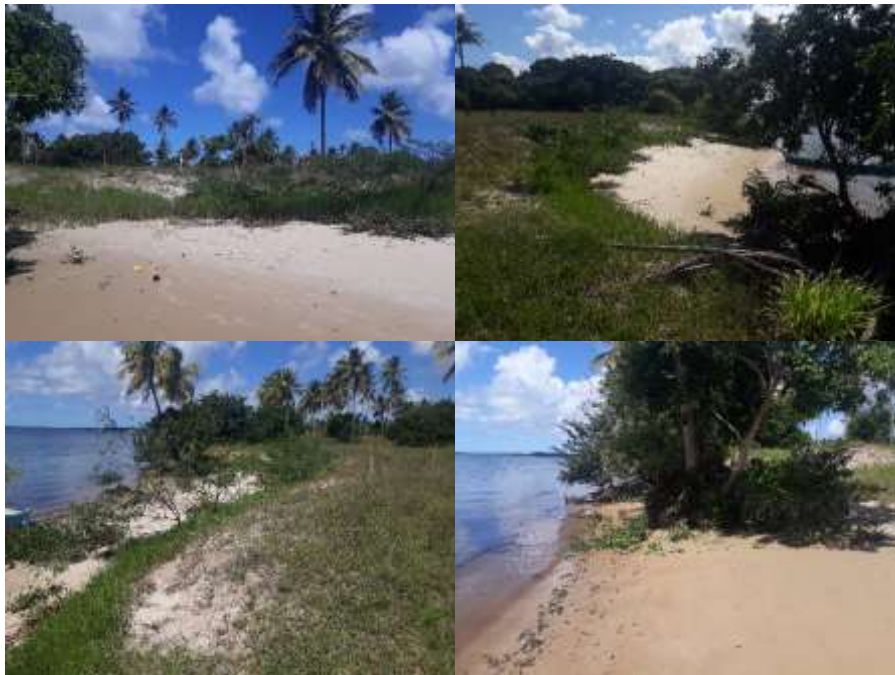
Figura 27 - Visão do talude na EM 5.2, constituído por solo arenoso, vazante com influência da maré.
