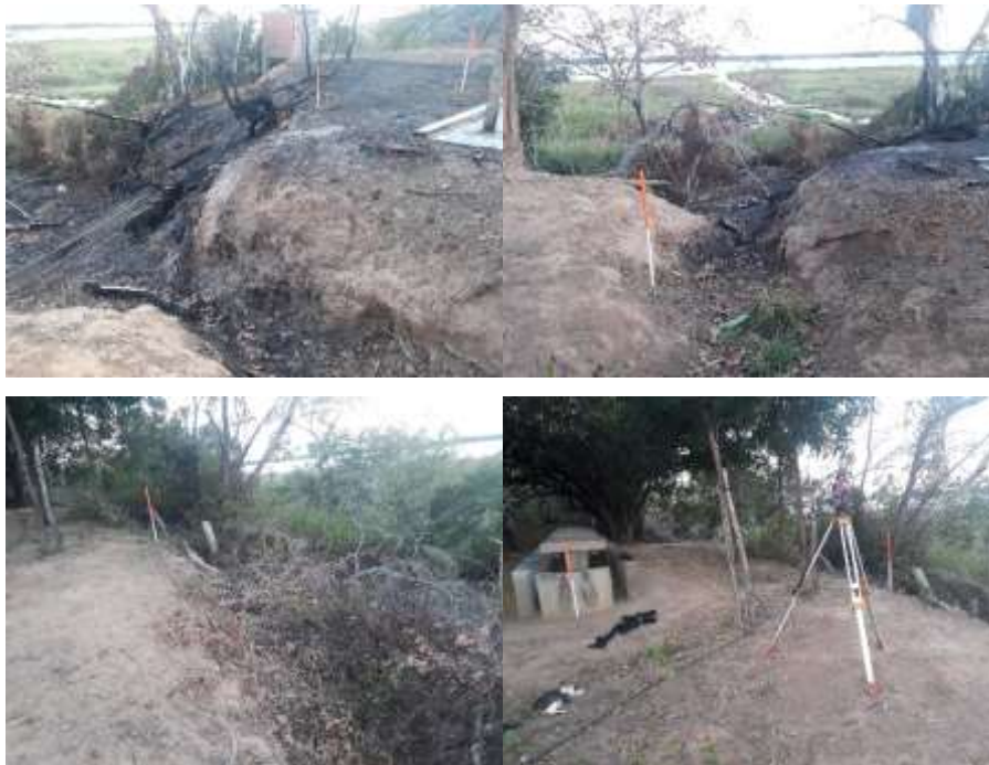
Figura 17 – Estação EM 2.1, erosão provocada pela ação antrópica e pluvial.
