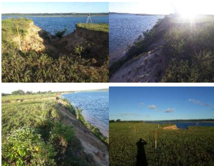
Figura 37 – Monitoramento Fotográfico da EM B-10 Talude destituído de vegetação ao nível d'água em solo arenoso.
