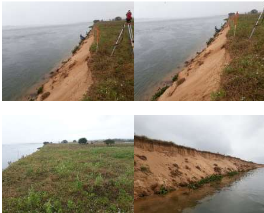
Figura 33 – Monitoramento Fotográfico da EM B-08. Talude destituído de vegetação ao nível d'água em solo arenoso.
