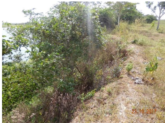
Foto 28 - Perfil longitudinal do talude.
