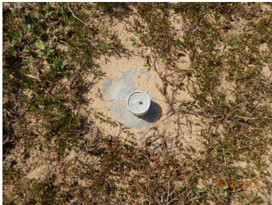
Foto 62 - Detalhe do Marco topográfico M-01.
