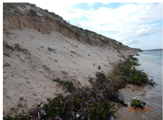
Foto 67 - Detalhe do solapamento da base do talude.
