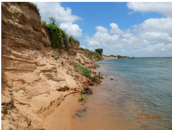
Foto 70 - Perfil longitudinal das paredes do talude com destaque para a elevada inclinação.
