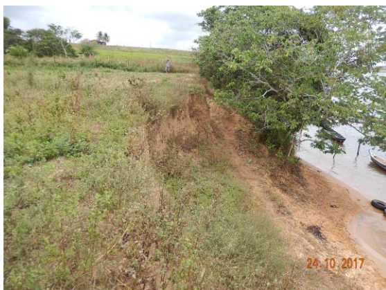
Foto 36 - Vista longitudinal da superfície do talude.
