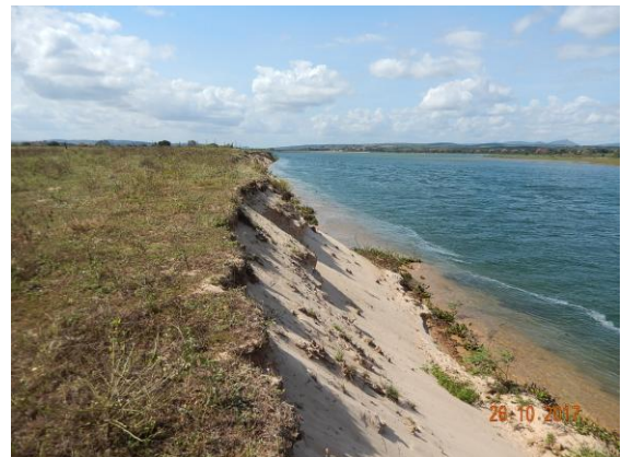
Foto 65 - Perfil longitudinal do talude.
