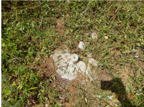
Foto 21 - Detalhe do marco topográfico M-01.
