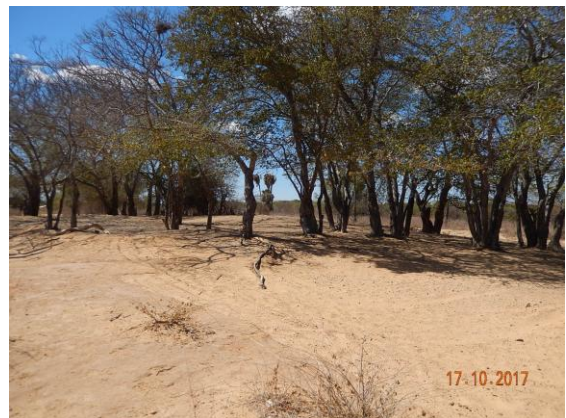
Foto 6 - Vista geral da porção superior do talude com indivíduos arbóreos isolados.
