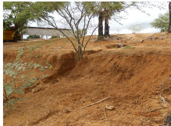
Foto 10- Perfil transversal da base do talude.
