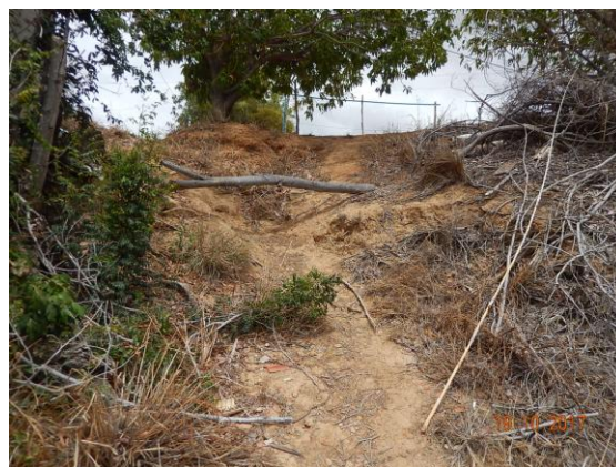
Foto 14 - Detalhe da porção frontal do talude.
