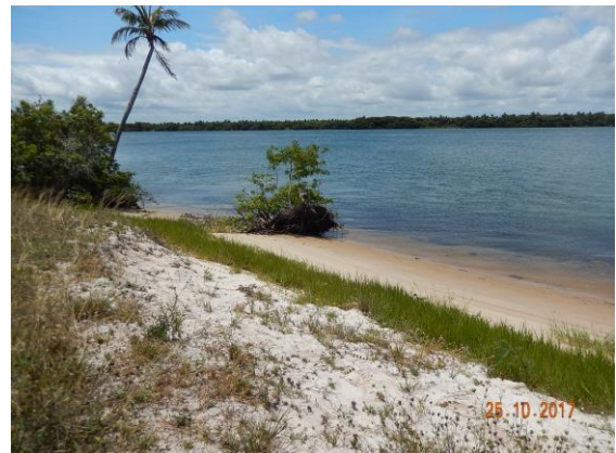
Foto 50 - Detalhe do talude erodido.
