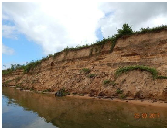
Foto 72 - Vista geral da frente do talude erodido.
