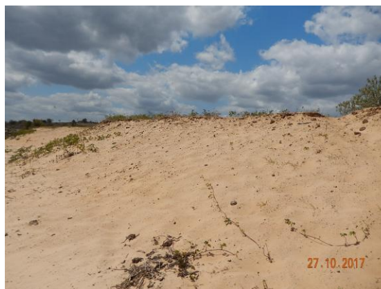
Foto 56 - Talude exposto com intenso pisoteamento de animais.
