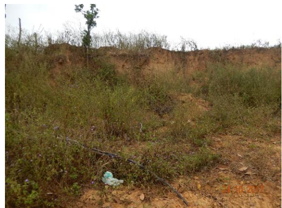
Foto 37 - Detalhe da porção frontal do talude erodida.
