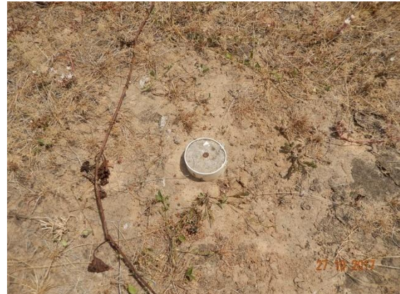
Foto 53 - Detalhe do marco topográfico M-02.
