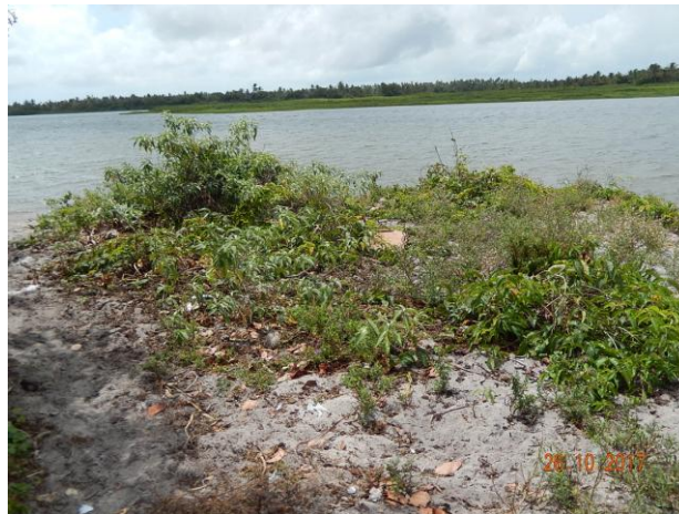
Foto 40 - Vista superior do talude.
