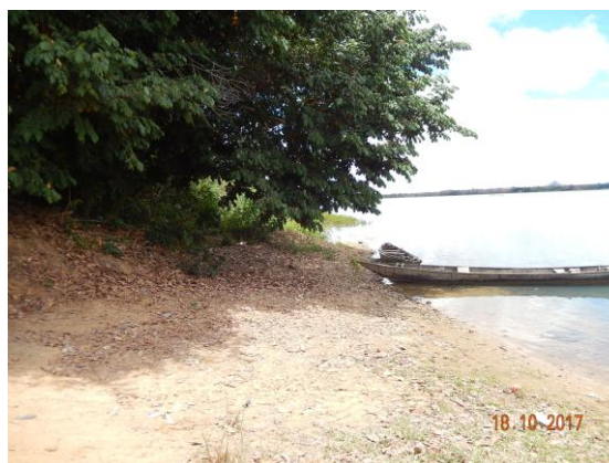
Foto 20 - Vista transversal do talude da margem do rio.
