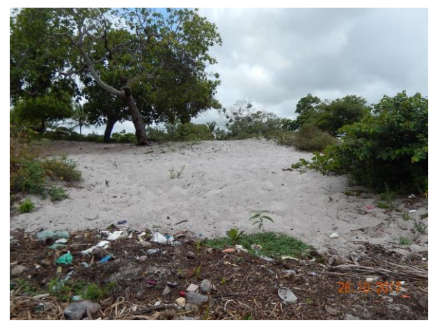
Foto 41 - Perfil frontal do talude.
