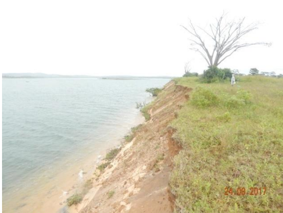
Foto 75 - Perfil longitudinal do topo do talude.
