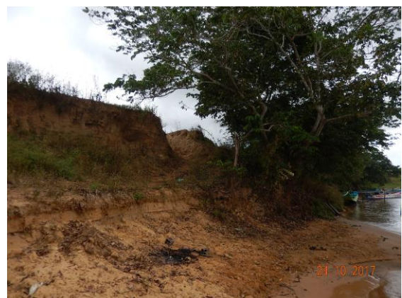
Foto 35 - Detalhe da porção frontal do talude monitorado.
