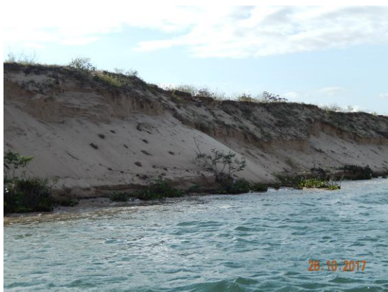
Foto 66 - Vista geral do intenso processo erosivo que ocorre na base do talude devido à ação das ondas.
