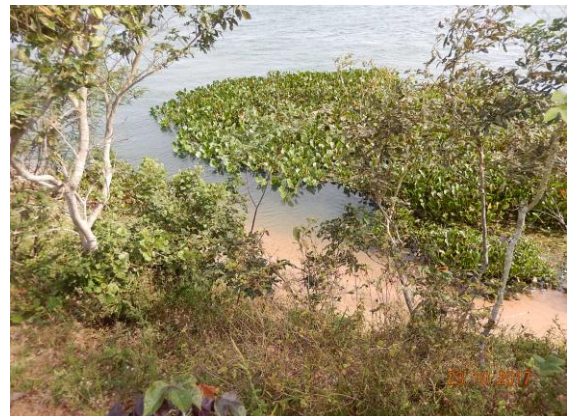
Foto 29 - Vista superior do talude.
