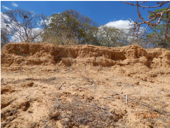
Foto 3 - Vista frontal do talude exposto.
