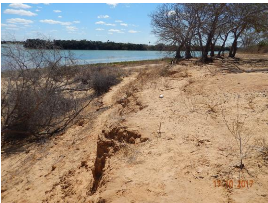
Foto 5 - Vista longitudinal da parte superior do talude.
