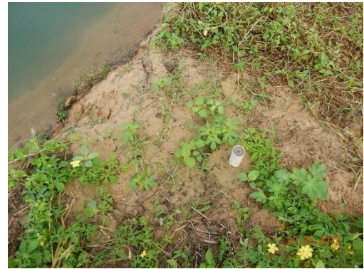
Foto 69 - Vista geral da parte superior do talude e do marco topográfico M-01.
