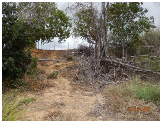
Foto 13 - Vista geral do talude.
