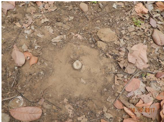
Foto 16 - Detalhe do marco topográfico M-02.
