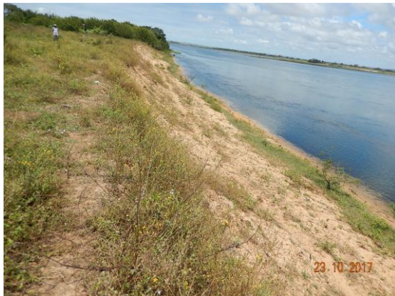
Foto 23 - Perfil longitudinal do talude.
