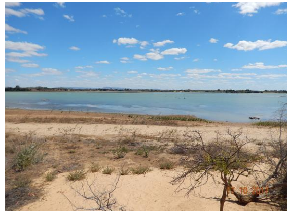
Foto 4 - Vista superior do talude em direção ao rio.
