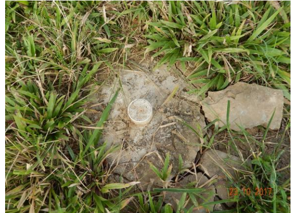
Foto 27 - Detalhe do marco topográfico M-02.
