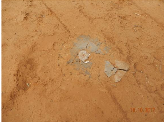
Foto 7 - Detalhe do marco topográfico M-01.
