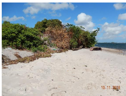
Foto 42 - Perfil transversal da base do talude.
