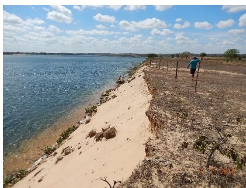
Foto 66 - Perfil longitudinal do talude.
