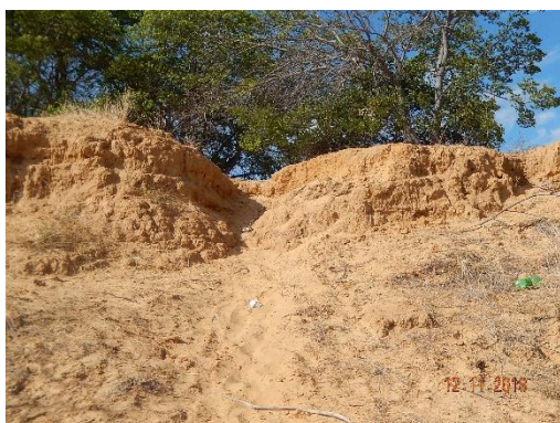
Foto 3- Vista frontal do talude exposto.
