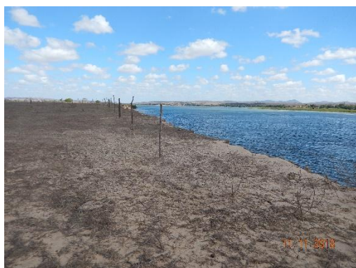
Foto 67 -Vista do topo do talude em direção ao rio.
