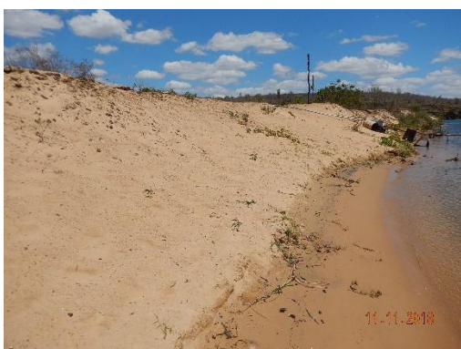
Foto 55- Perfil longitudinal do talude monitorado.
