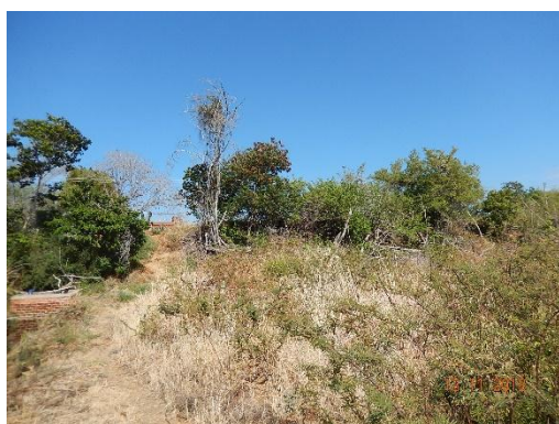
Foto 15 - Detalhe da porção frontal do talude.
