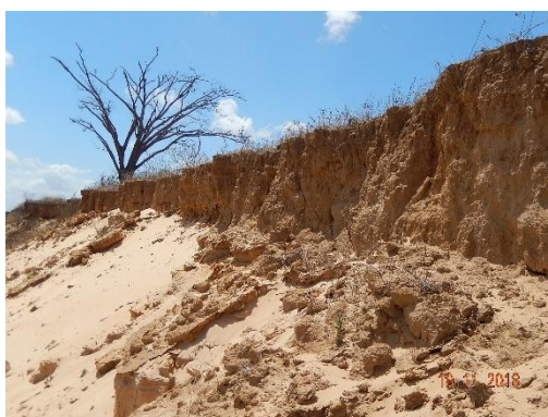
Foto 78-Detalhe do solapamento de topo do talude.
