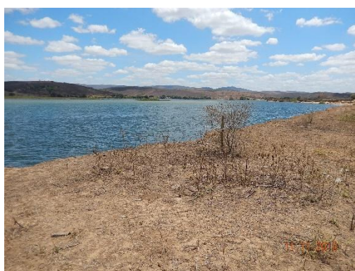
Foto 61 - Vista superior do talude.
