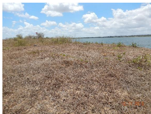
Foto 73 - Vista geral do topo do talude.
