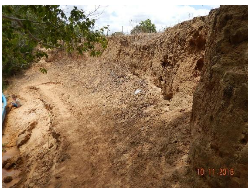
Foto 37 - Vista longitudinal da superfície do talude.
