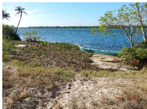
Foto 51-Vista do topo do talude em direção ao rio.
