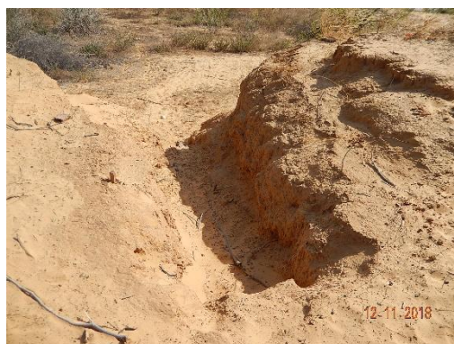
Foto 4- Vista superior da feição erosiva que ocorre no talude monitorado.
