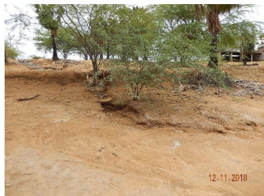
Foto 10-Perfil transversal da base do talude.
