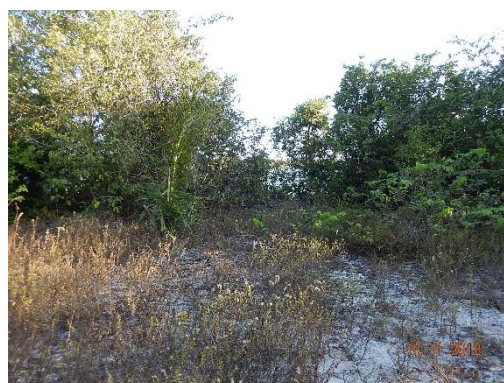
Foto 47 - Vista da porção superior do talude.
