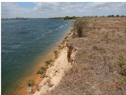
Foto 71 - Perfil longitudinal das paredes do talude.
