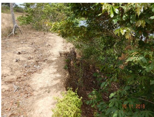
Foto 29-Perfil longitudinal do talude.
