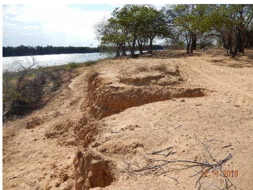
Foto 5- Vista longitudinal da parte superior do talude.
