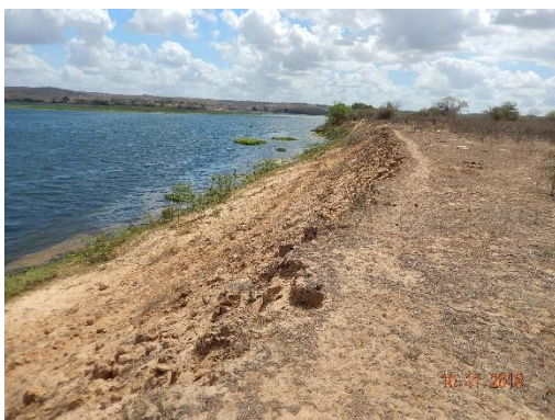
Foto 24 - Perfil longitudinal do talude.
