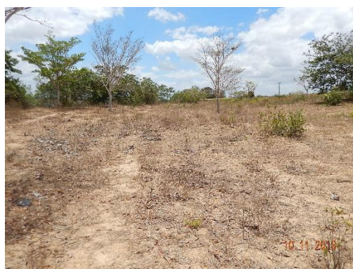
Foto 30-Vista superior do talude.
