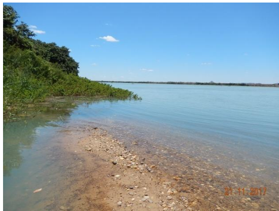
Foto 20 - Vista transversal do talude da margem do rio.
