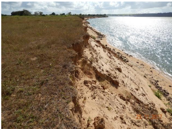
Foto 75 - Perfil longitudinal do topo do talude.
