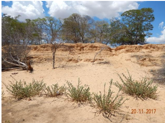
Foto 3 - Vista frontal do talude exposto.
