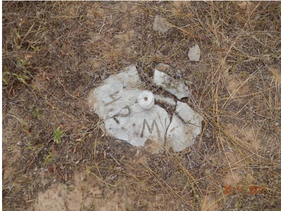
Foto 21 - Detalhe do marco topográfico M-01.
