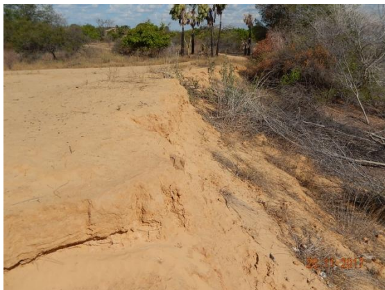
Foto 5 - Vista longitudinal da parte superior do talude.
