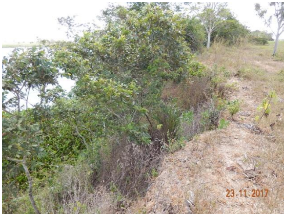
Foto 28 - Perfil longitudinal do talude.
