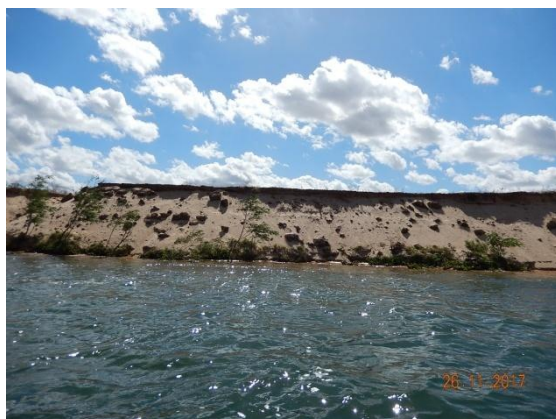
Foto 66 - Vista geral frontal do talude monitorado.
