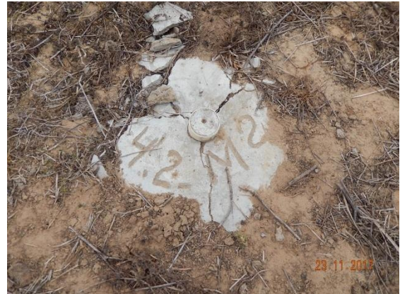
Foto 22 - Detalhe do marco topográfico M-02.
