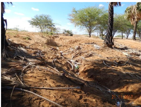
Foto 11 - Vista transversal da feição erosiva monitorada.
