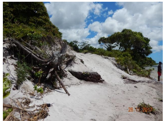
Foto 41 - Perfil transversal do talude.
