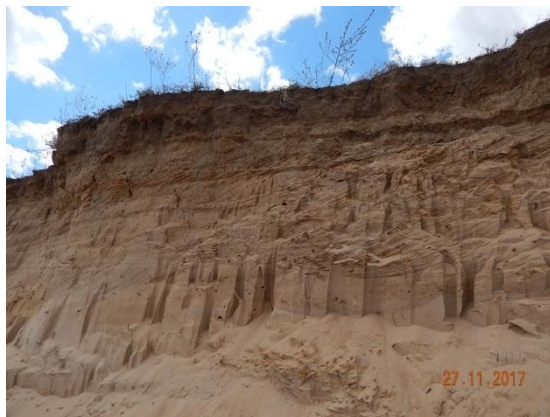
Foto 61 - Detalhe do intenso processo erosivo e acentuada inclinação do talude.
