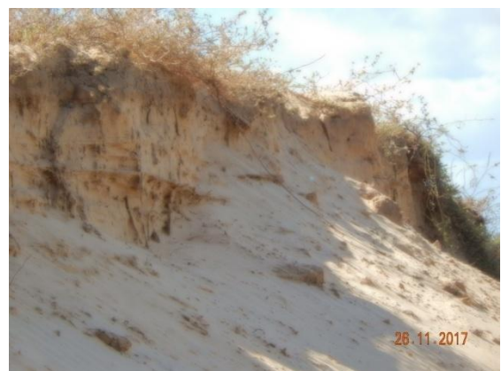
Foto 67 - Detalhe do solapamento da base do talude.
