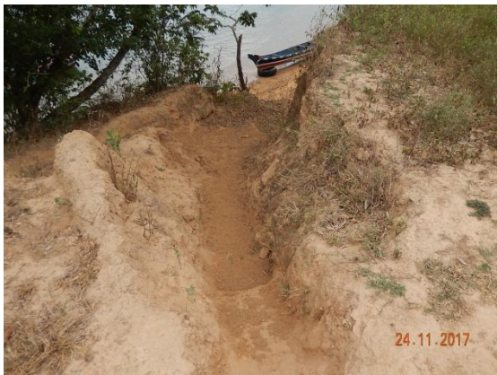
Foto 34 - Vista da superior do talude com detalhe para a feição erosiva oriunda principalmente por ação antrópica.
