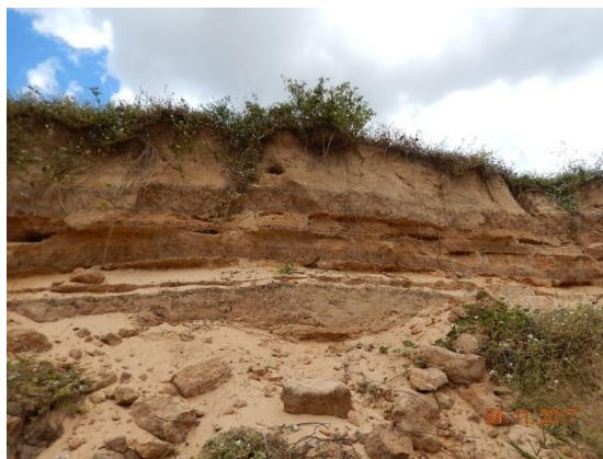
Foto 72 - Vista geral da frente do talude com detalhe na erosão.
