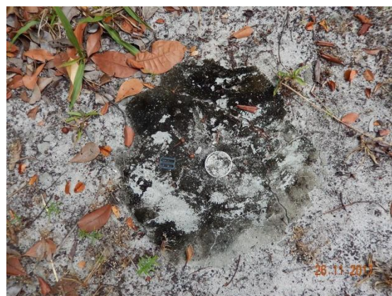
Foto 44 - Detalhe do marco topográfico M-02.
