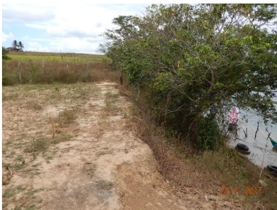
Foto 36 - Vista longitudinal da superfície do talude.
