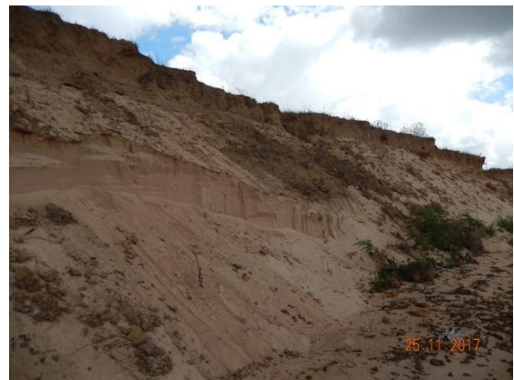
Foto 76 - Desmoronamento da base.
