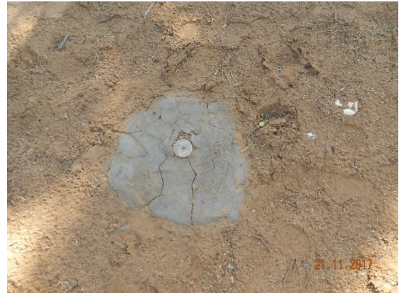
Foto 8 - Detalhe do marco topográfico M-02.
