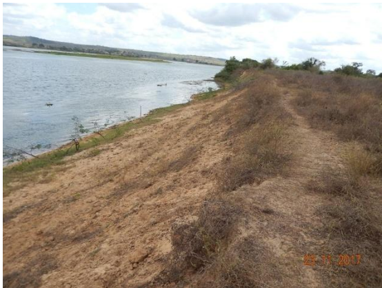
Foto 23 - Perfil longitudinal do talude.
