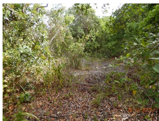
Foto 46 - Vista da porção superior do talude.
