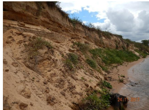
Foto 71 - Intenso processo de erosão com destaque para o desmoronamento de parte do talude.
