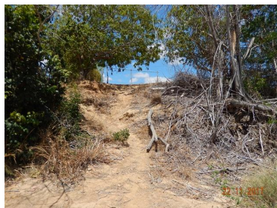
Foto 14 - Detalhe da porção frontal do talude.
