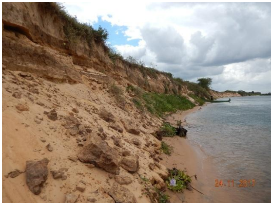
Foto 70 - Perfil longitudinal das paredes do talude com destaque para a elevada inclinação.
