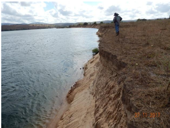
Foto 59 - Perfil do talude monitorado.
