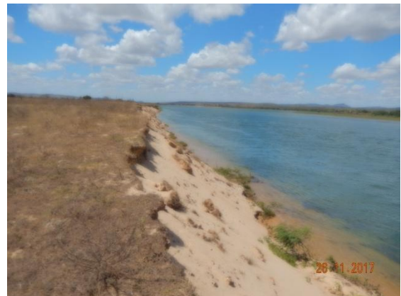
Foto 65 - Perfil longitudinal do talude.
