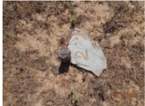
Foto 63 - Detalhe do Marco topográfico M-02.
