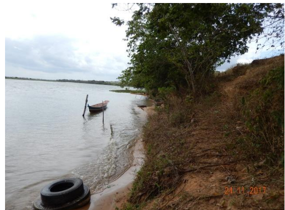
Foto 35 - Vista do talude com a margem do rio.
