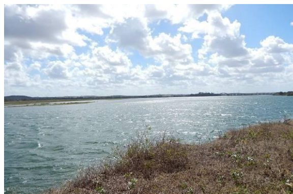
Foto 73 - Vista geral do topo do talude.
