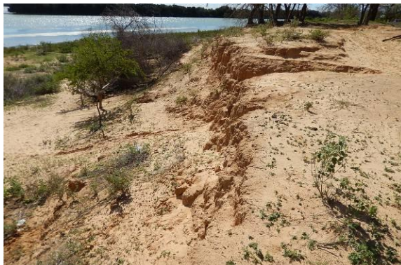
Foto 5 - Vista longitudinal da parte superior do talude.
