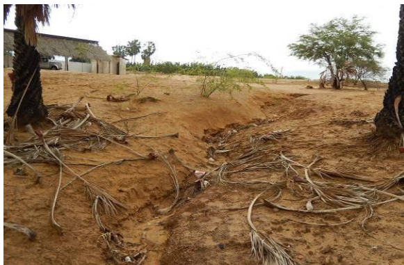
Foto 9 - Feição erosiva que ocorre na área de monitoramento.
