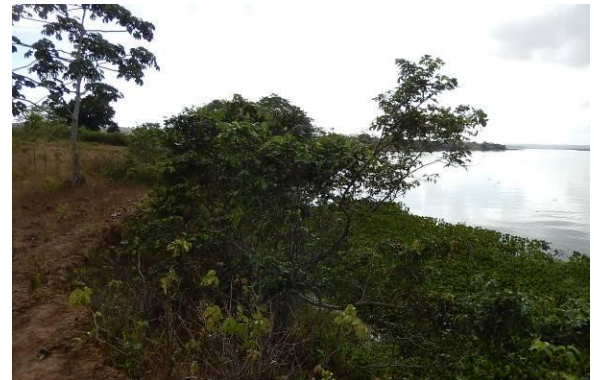
Foto 30 - Vista superior do talude.
