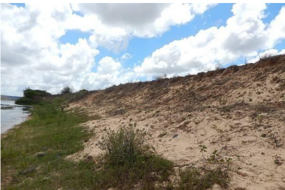
Foto 24 - Perfil longitudinal do talude.
