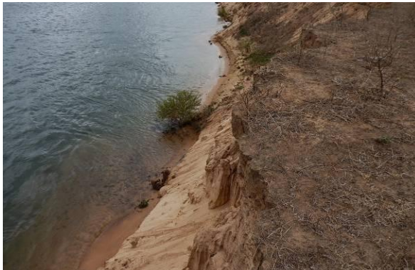
Foto 60 - Perfil do talude monitorado.
