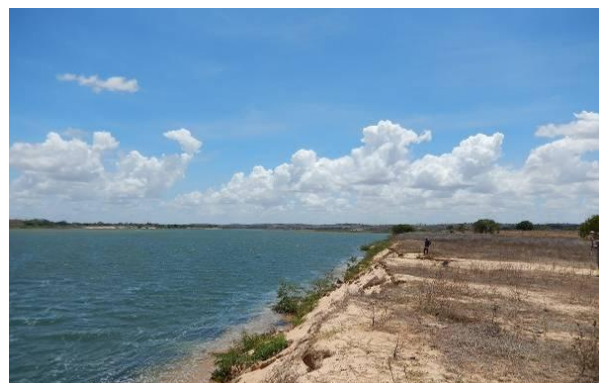
Foto 66 - Perfil longitudinal do talude.
