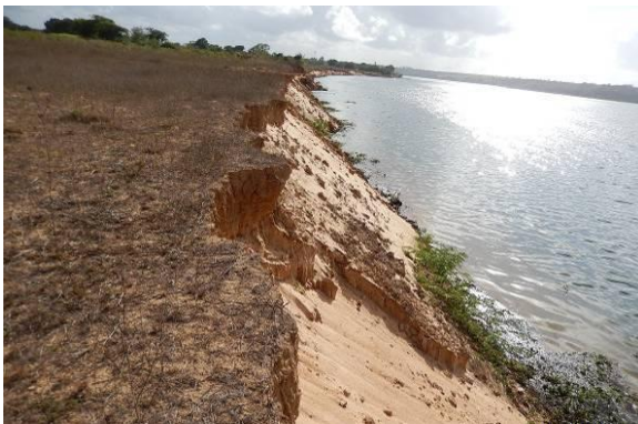
Foto 76 - Perfil longitudinal do topo do talude.
