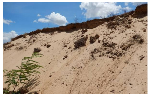
Foto 68 - Detalhe do solapamento da base do talude.
