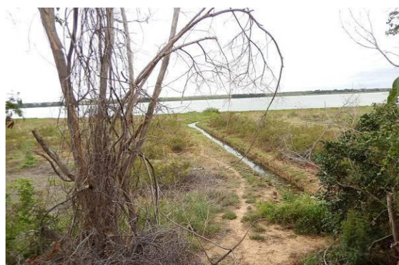
Foto 16 - Vista superior do talude em direção ao rio.
