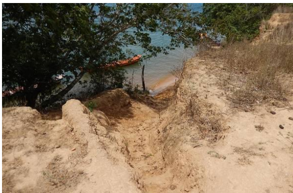
Foto 35 - Vista do talude com detalhe para a feição erosiva oriunda principalmente por ação antrópica.
