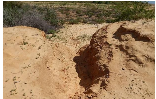
Foto 4 - Vista superior da feição erosiva que ocorre no talude monitorado.
