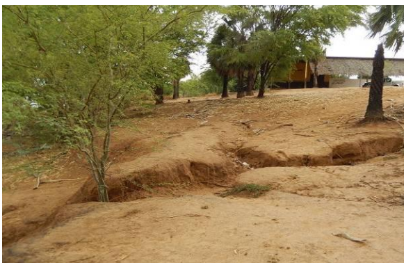
Foto 11 - Vista transversal da feição erosiva monitorada.
