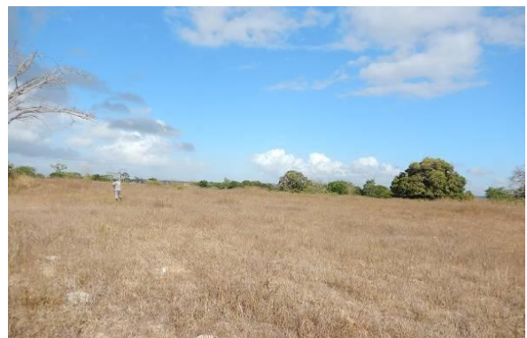
Foto 77 - Vista do topo do talude.
