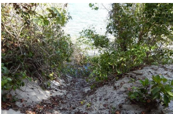
Foto 46 - Feição erosiva existente no local.
