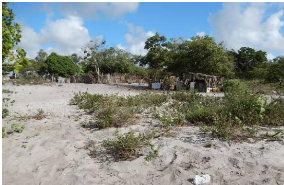
Foto 41 - Vista superior do talude.
