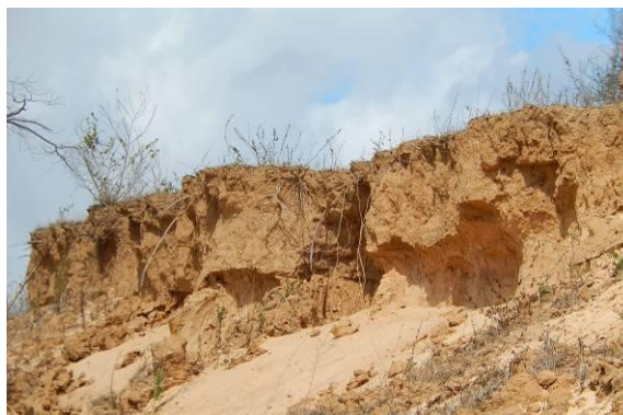
Foto 78 - Detalhe do solapamento de topo do talude.
