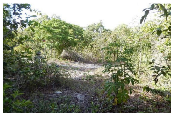
Foto 47 - Vista da porção superior do talude.
