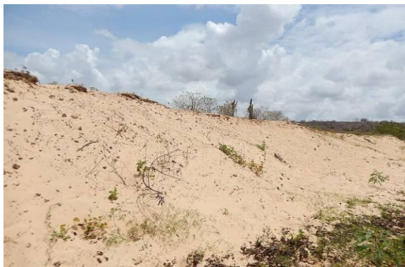
Foto 55- Perfil longitudinal do talude monitorado.
