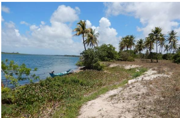
Foto 50 - Vista longitudinal do talude.
