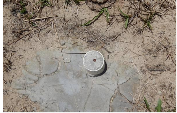
Foto 49 - Detalhe do marco topográfico M-02.
