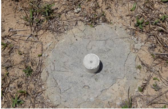
Foto 48 - Detalhe do marco topográfico M-01.
