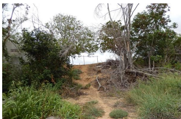
Foto 15 - Detalhe da porção frontal do talude.
