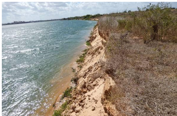
Foto 71 - Perfil longitudinal das paredes do talude.
