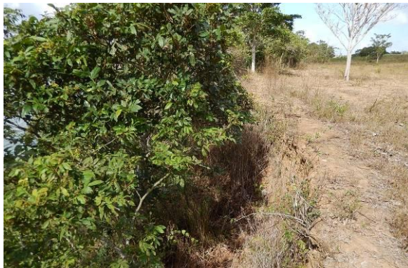
Foto 29 - Perfil longitudinal do talude.
