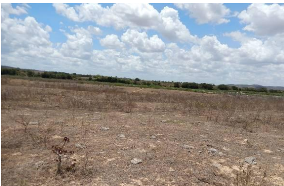
Foto 65 - Vista geral da parte superior do talude.
