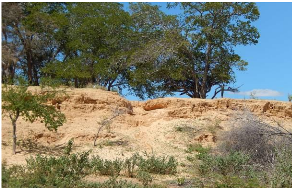
Foto 3 - Vista frontal do talude exposto.
