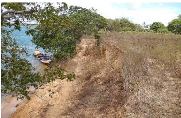
Foto 37 - Vista longitudinal da superfície do talude.
