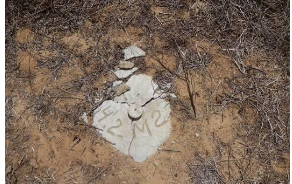
Foto 23 - Detalhe do marco topográfico M-02.
