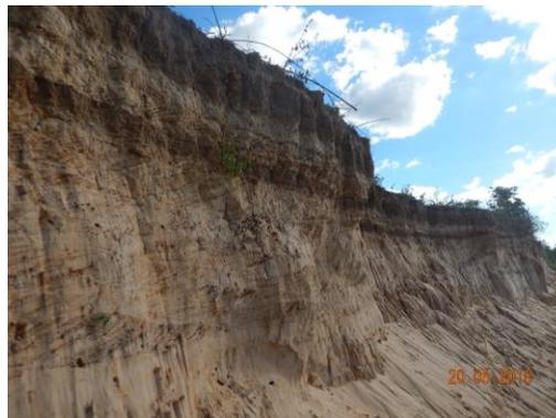
**Foto 62 - Detalhe do intenso processo erosivo e acentuada inclinação do talude.**
