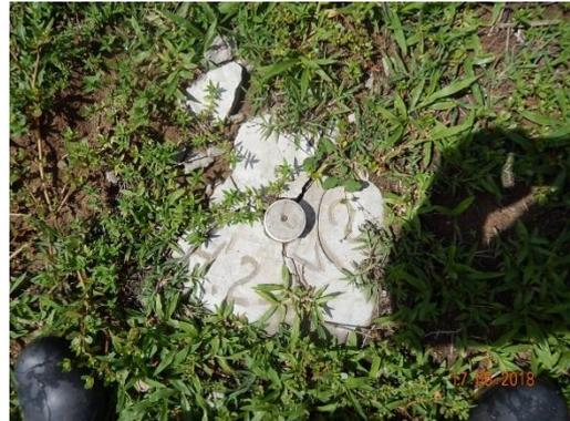
**Foto 23 - Detalhe do marco topográfico M-02.**
