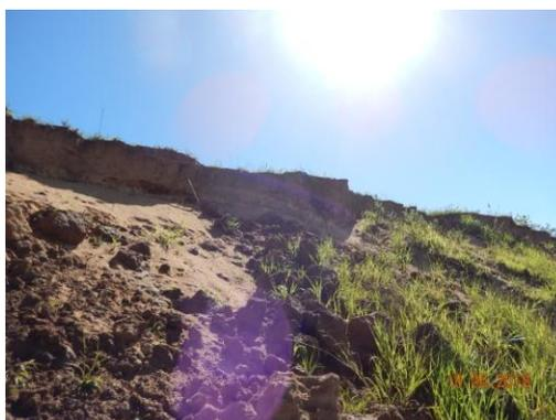
**Foto 78 - Detalhe do solapamento de topo do talude.**
