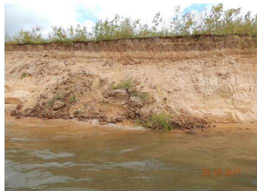
Foto 65 - Vista da frente do talude com destaque para o ativo desmoronamento da crista.
