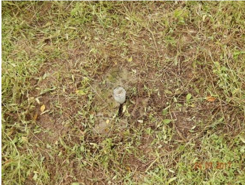
Foto 22 - Detalhe do marco topográfico M-01.
