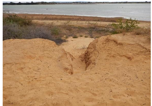
Foto 4 - Vista superior do talude com detalhe para a feição erosiva no interior da foto.
