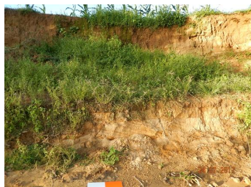
Foto 37 - Detalhe da frente do talude monitorado.
