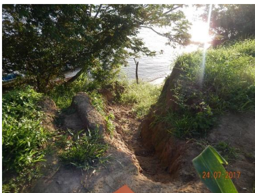
Foto 36 - Vista da superior do talude com detalhe para a feição erosiva oriunda principalmente por ação antrópica.
