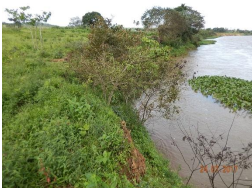
Foto 30 - Perfil longitudinal do talude.
