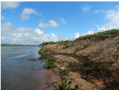
Foto 58 - Perfil longitudinal do talude monitorado.
