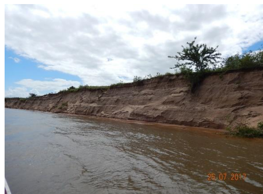
Foto 79 - Vista geral da frente do talude erodido.
