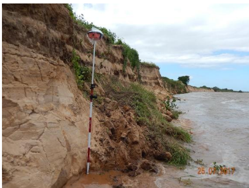
Foto 78 - Intenso processo de erosão com destaque para o desmoronamento de parte do talude.
