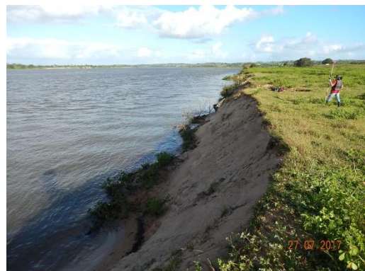
Foto 71 - Perfil longitudinal do talude.
