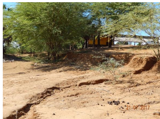
Foto 10 - Perfil transversal da base do talude.
