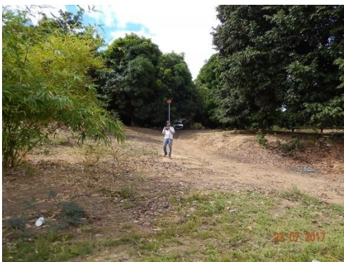
Foto 20 - Vista frontal do talude.
