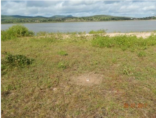
Foto 56 - Vista geral do topo do talude monitorado, marco topográfico M-01.
