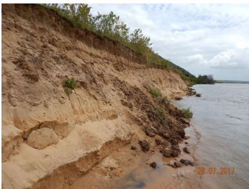
Foto 66 - Detalhe do intenso processo erosivo e acentuada inclinação do talude.
