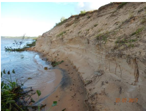
Foto 72 - Vista geral do intenso processo erosivo que ocorre na base do talude devido a ação das ondas.
