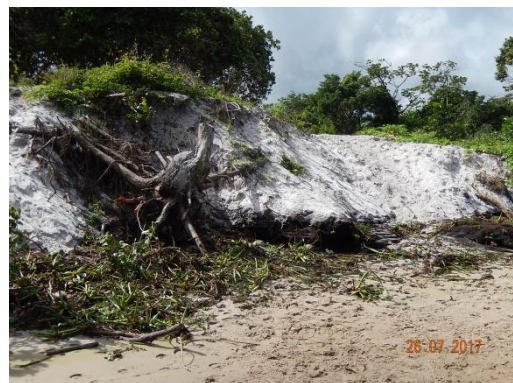
Foto 43 - Perfil longitudinal do talude.
