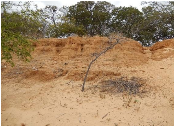
Foto 3 - Vista frontal do talude exposto.
