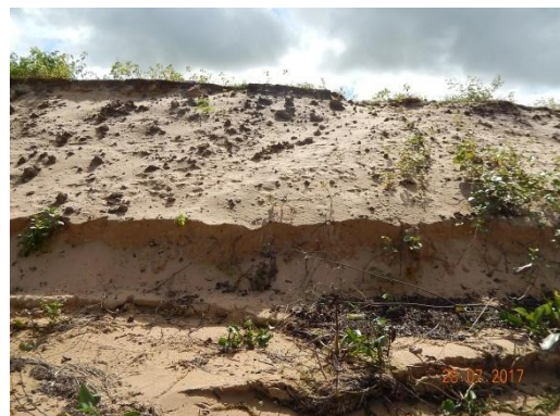
Foto 59 - Processo de solapamento da base do talude causado pela ação das ondas no processo de erosão fluvial.
