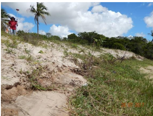
Foto 54 - Detalhe do talude erodido.
