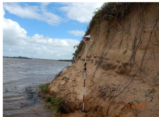
Foto 77 - Detalhe da altura do talude.
