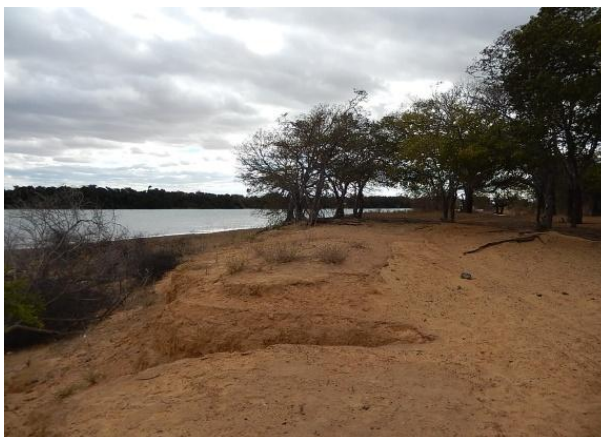
Foto 5 - Vista longitudinal da parte superior do talude.
