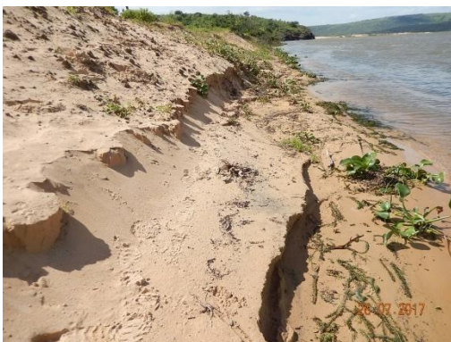
Foto 60 - Detalhe do processo de erosão fluvial e solapamento do talude.
