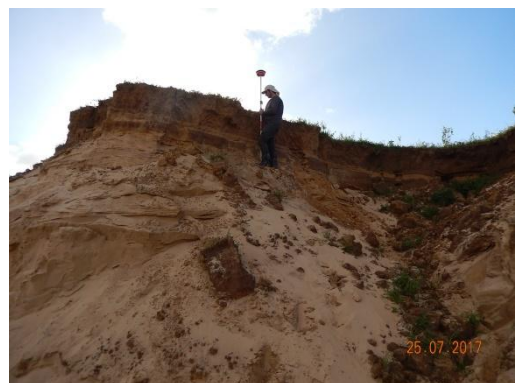
Foto 85 - Mapeamento realizado no topo do talude.
