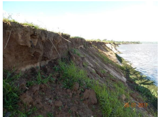
Foto 83 - Desmoronamento da camada argilosa no topo do talude.
