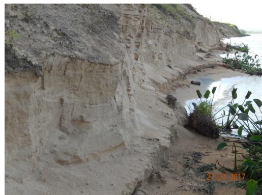
Foto 73 - Detalhe do solapamento da base do talude.
