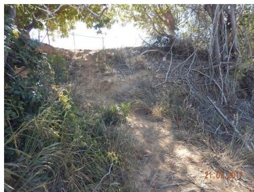
Foto 14 - Detalhe da porção frontal do talude
