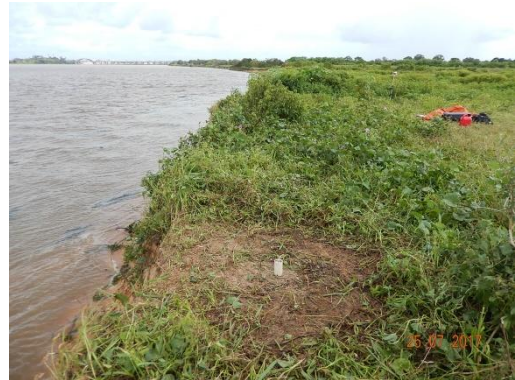
Foto 75 - Vista geral da parte superior do talude e do marco topográfico M-01.
