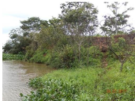
Foto 31 - Vista frontal do talude.
