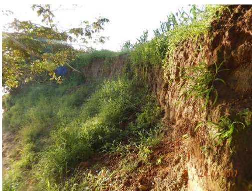
Foto 38 - Vista longitudinal da parede do talude.
