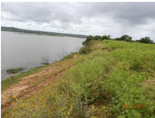
Foto 24 - Perfil longitudinal do talude.
