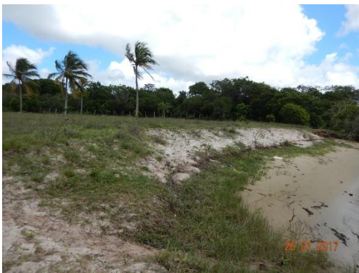
Foto 52 - Vista longitudinal do talude.
