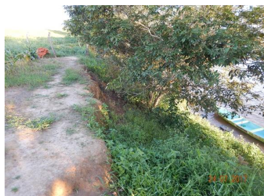
Foto 39 - Perfil longitudinal da crista do talude.
