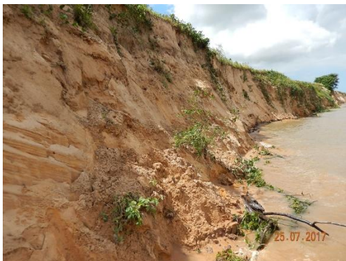
Foto 76 - Perfil longitudinal das paredes do talude com destaque para a elevada inclinação.
