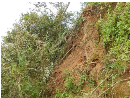
Foto 32 - Detalhe da elevada inclinação do talude e exposição do solo.
