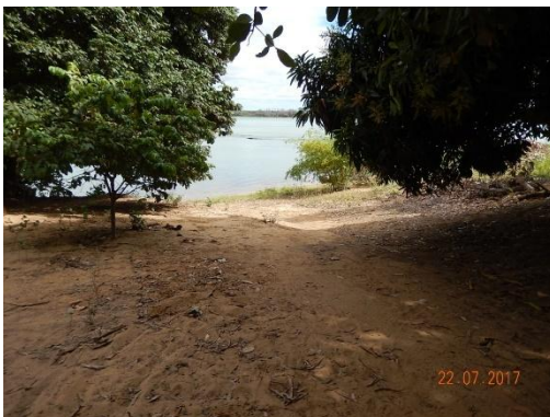
Foto 18 - Parte superior do talude.
