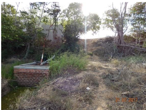
Foto 13 - Vista geral do talude
