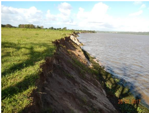
Foto 82 - Perfil longitudinal do talude.
