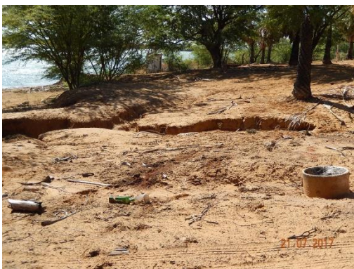
Foto 11 - Perfil transversal do topo do talude.
