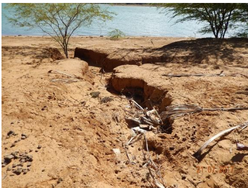
Foto 9 - Feição erosiva que ocorre na área de monitoramento
