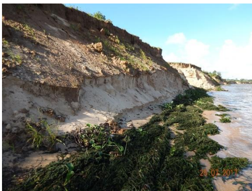
Foto 84 - Solapamento da base do talude de ação das ondas.
