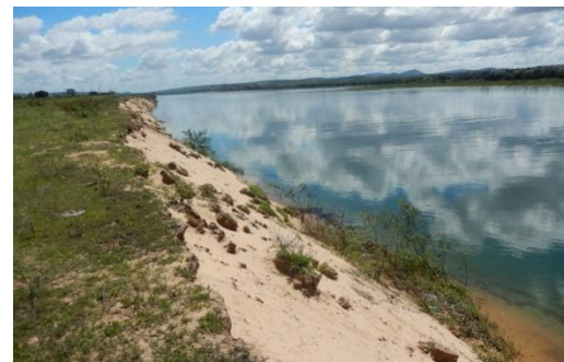
Foto 66 - Perfil longitudinal do talude.
