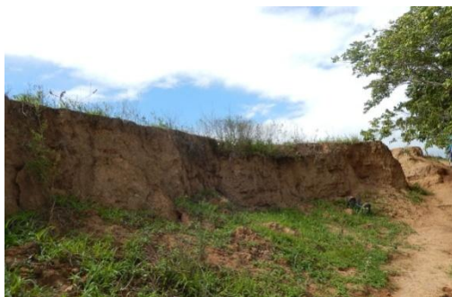
Foto 37 - Vista longitudinal da superfície do talude.
