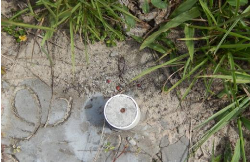
Foto 48 - Detalhe do marco topográfico M-01.
