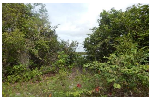
Foto 47 - Vista da porção superior do talude.
