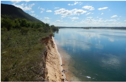
Foto 60 - Perfil do talude monitorado.
