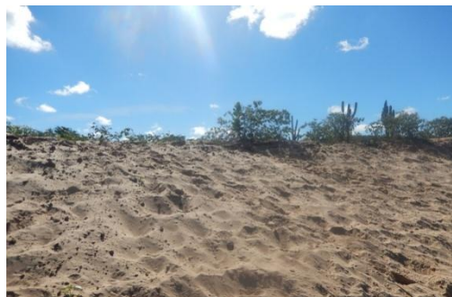
Foto 57 - Vista frontal do talude.
