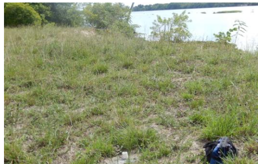
Foto 51 - Vista do topo do talude em direção ao rio.
