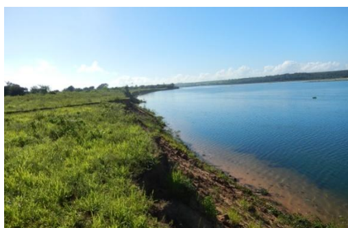
Foto 76 - Perfil longitudinal do topo do talude.
