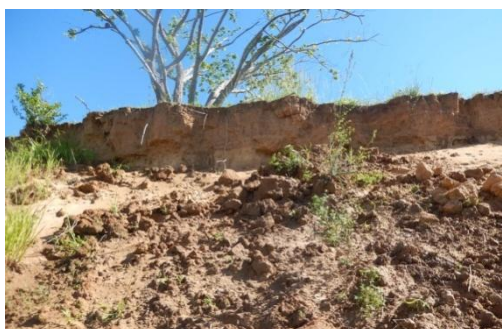
Foto 78 - Detalhe do solapamento de topo do talude.
