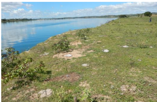
Foto 67 - Vista do topo do talude em direção ao rio.
