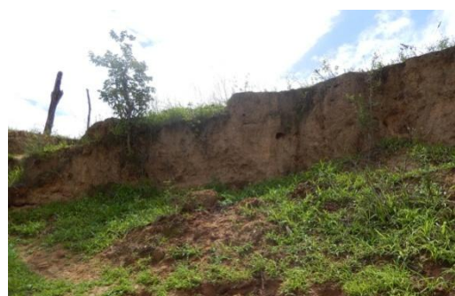
Foto 36 - Vista frontal do talude.
