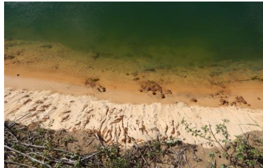
Foto 61 - Vista superior do talude.
