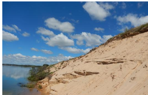
Foto 68 - Detalhe do solapamento da base do talude.
