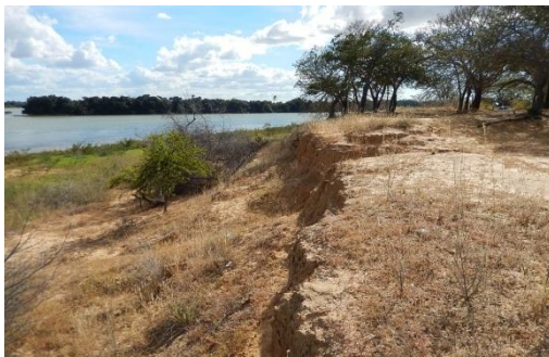
Foto 5 - Vista longitudinal da parte superior do talude.
