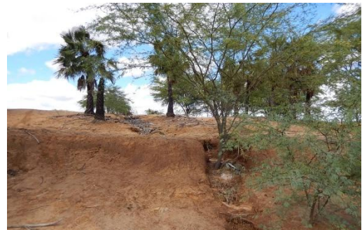
Foto 10 - Perfil transversal da base do talude.
