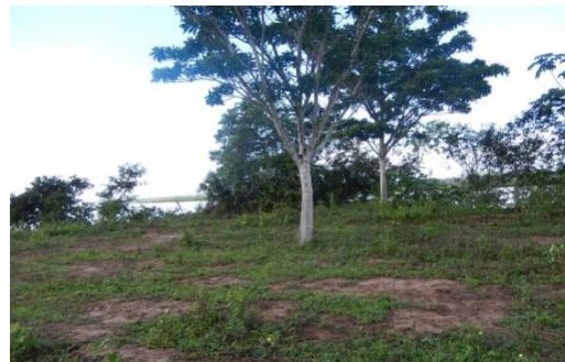
Foto 30 - Vista superior do talude.
