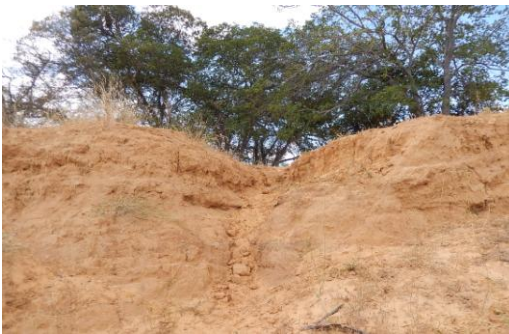
Foto 3 - Vista frontal do talude exposto.
