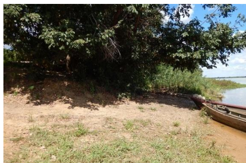
Foto 21 - Vista transversal do talude da margem do rio.
