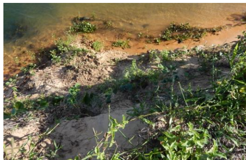
Foto 73 - Vista geral do topo do talude.
