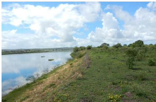
Foto 24 - Perfil longitudinal do talude.
