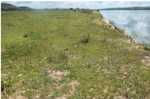
Foto 65 - Vista geral da parte superior do talude.
