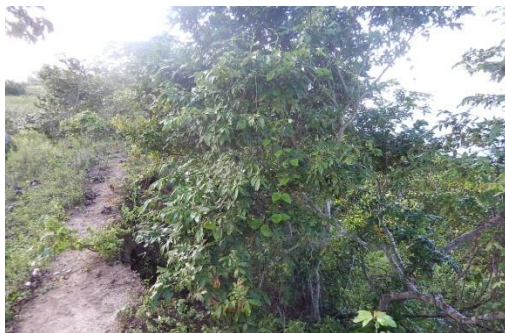
Foto 29 - Perfil longitudinal do talude.
