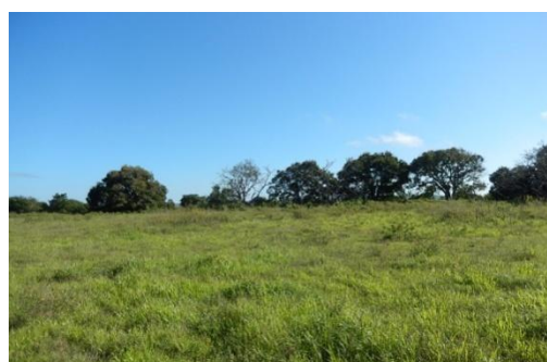
Foto 77 - Vista do topo do talude.
