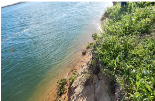
Foto 71 - Perfil longitudinal das paredes do talude.
