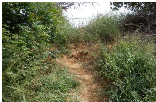
Foto 15 - Detalhe da porção frontal do talude.
