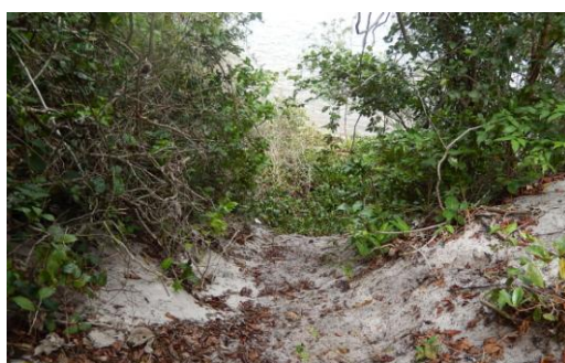
Foto 46 - Feição erosiva existente no local.
