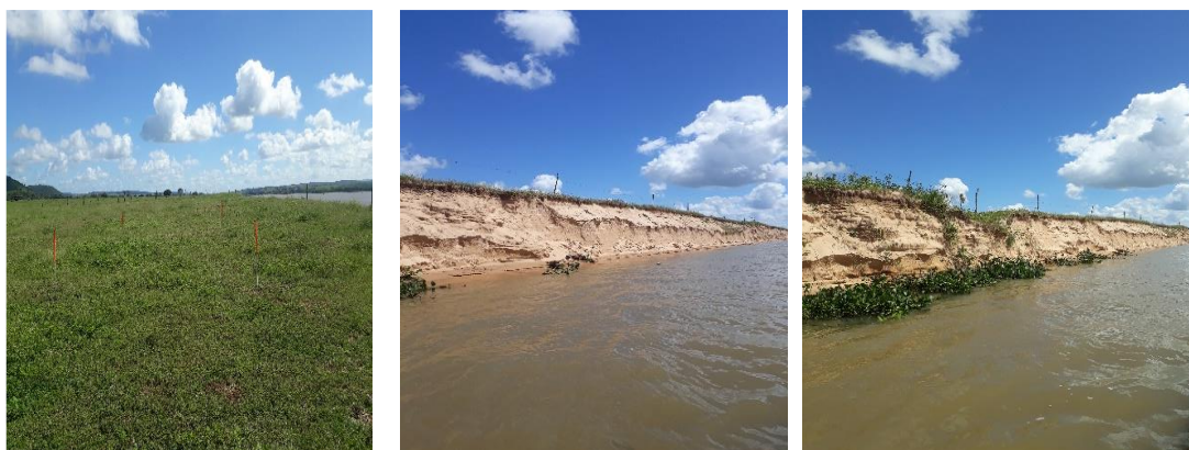
Figura 34 - EM B-08. Talude destituído de vegetação
