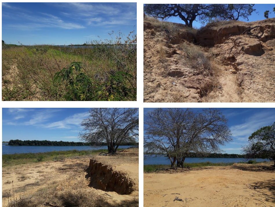
Figura 13 – Estação EM 1.1 com visão do barranco
