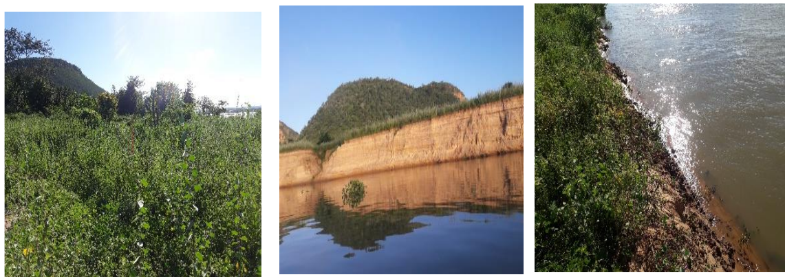
Figura 32 - EM B-06. Talude destituído de vegetação até o nível d'água.
