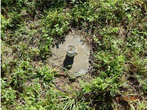
**Foto 75 - Marco topográfico M-02.**
