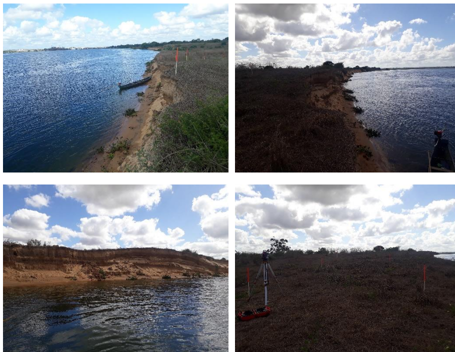
Figura 35 – Monitoramento Fotográfico da EM B-09. Talude destituído de vegetação ao nível d'água em solo arenoso.
