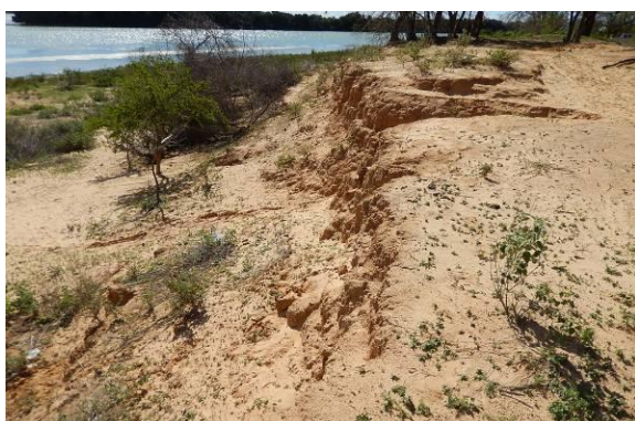
Foto 5 - Vista longitudinal da parte superior do talude.
