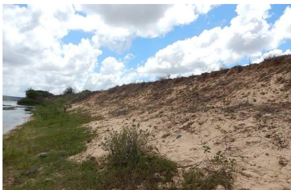
Foto 24 - Perfil longitudinal do talude.
