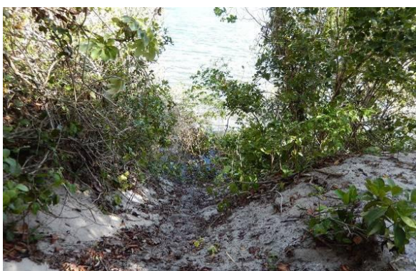
Foto 46 - Feição erosiva existente no local.
