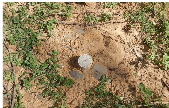
Foto 2 - Detalhe do marco topográfico M-02.
