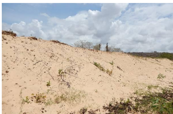
Foto 55 - Perfil longitudinal do talude monitorado.
