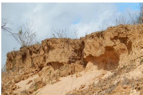
Foto 78 - Detalhe do solapamento de topo do talude.
