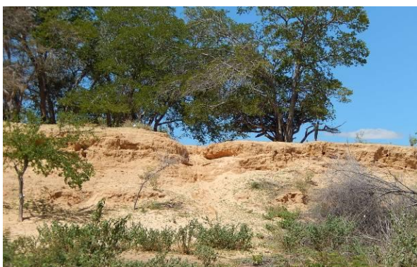
Foto 3 - Vista frontal do talude exposto.
