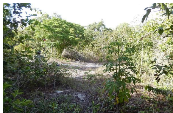
Foto 47 - Vista da porção superior do talude.
