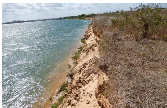
Foto 71 - Perfil longitudinal das paredes do talude.
