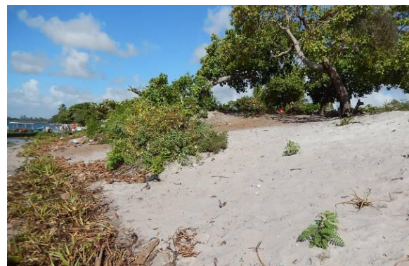
Foto 42 - Perfil transversal da base do talude.
