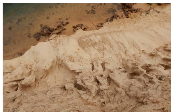
Foto 61 - Vista superior do talude.
