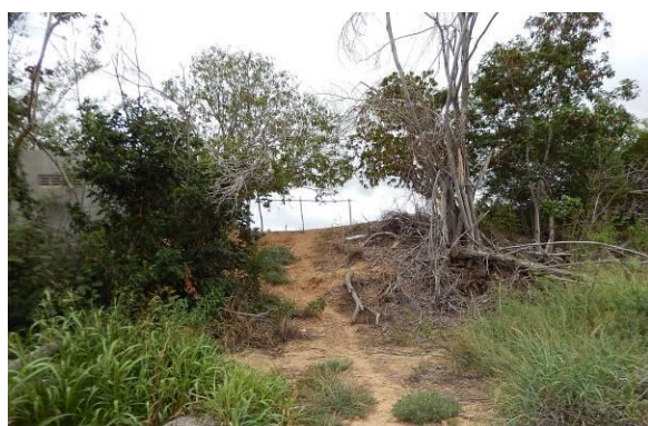
Foto 15 - Detalhe da porção frontal do talude.
