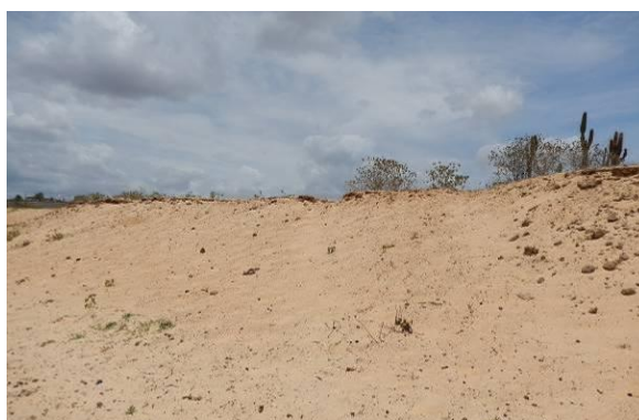
Foto 57 - Vista frontal do talude.
