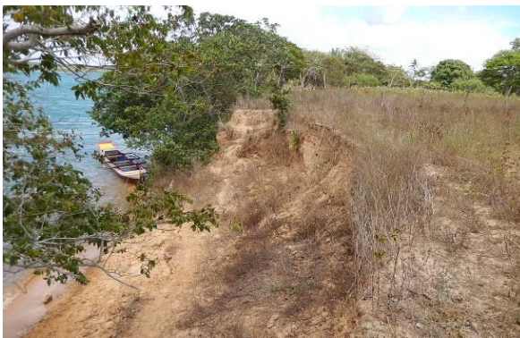
Foto 37 - Vista longitudinal da superfície do talude.
