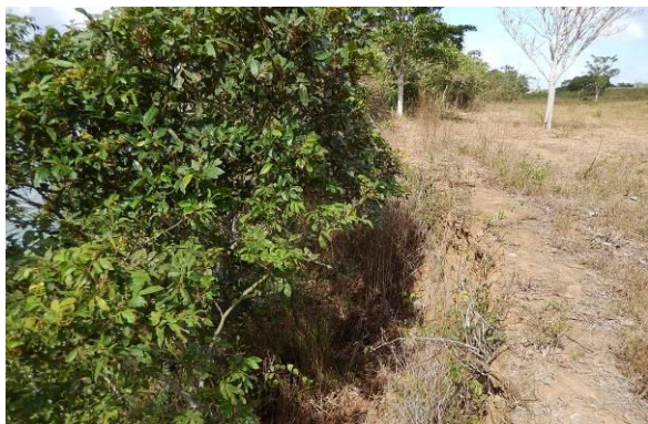
Foto 29 - Perfil longitudinal do talude.
