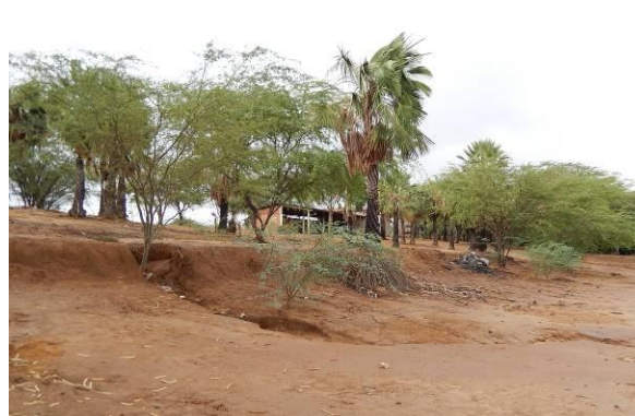
Foto 10 - Perfil transversal da base do talude.
