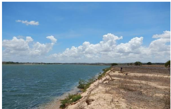
Foto 66 - Perfil longitudinal do talude.
