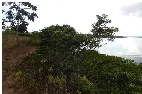
Foto 30 - Vista superior do talude.
