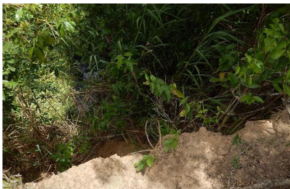
Foto 31- Detalhe da elevada inclinação do talude e exposição do solo.
