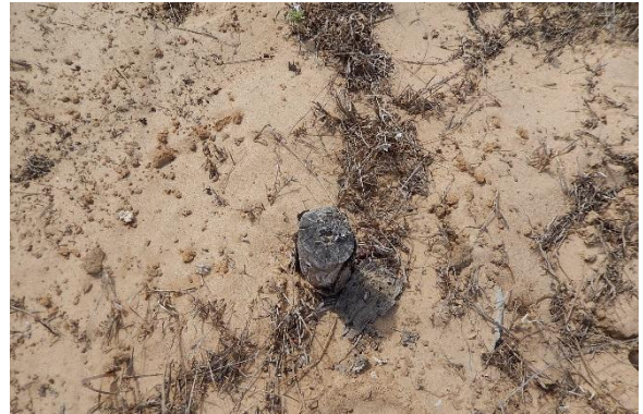
Foto 64 - Detalhe do Marco topográfico M-02.
