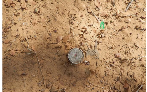
Foto 2 - Detalhe do marco topográfico M-02.
