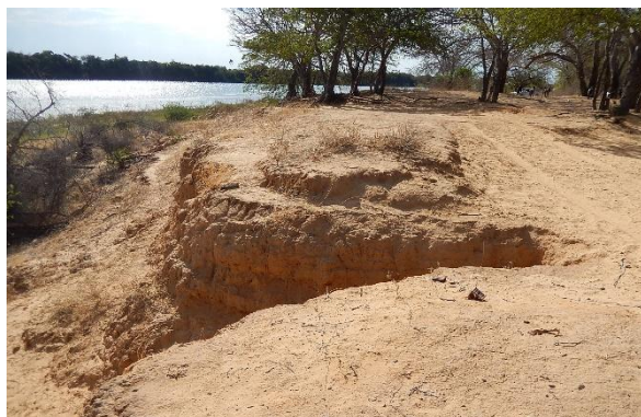
Foto 5- Vista longitudinal da parte superior do talude.
