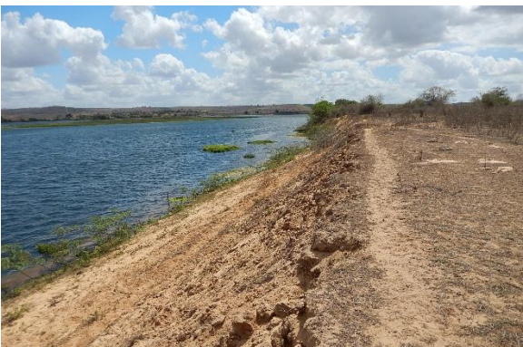
Foto 24 - Perfil longitudinal do talude.
