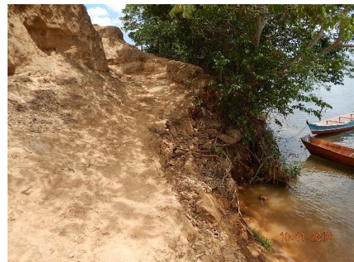
Foto 36 - Vista frontal do talude.
