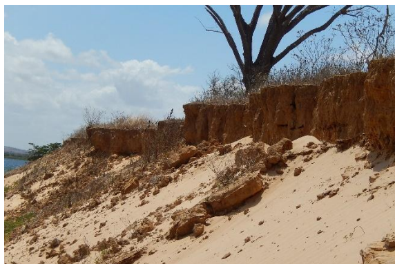
Foto 78 - Detalhe do solapamento de topo do talude.
