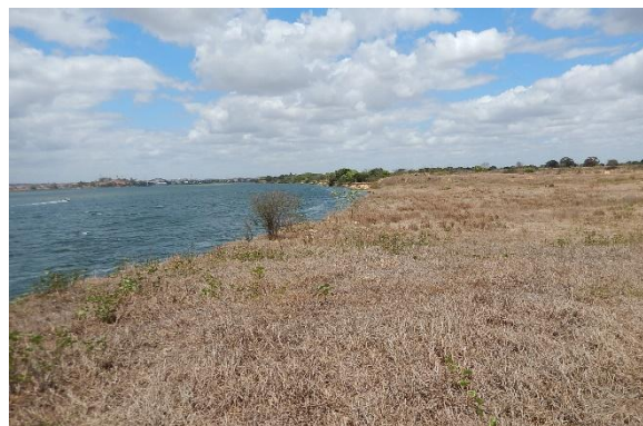
Foto 73 - Vista geral do topo do talude.
