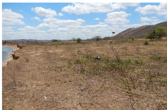
Foto 61 - Vista superior do talude.
