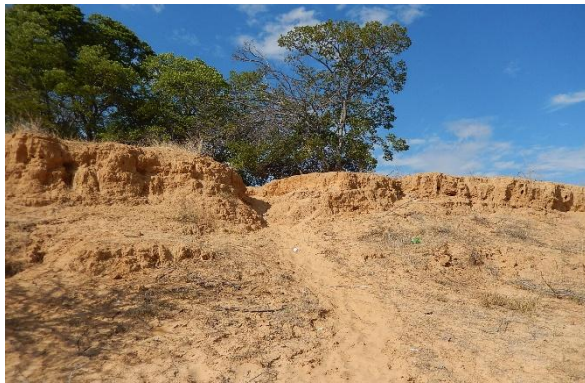
Foto 3- Vista frontal do talude exposto.
