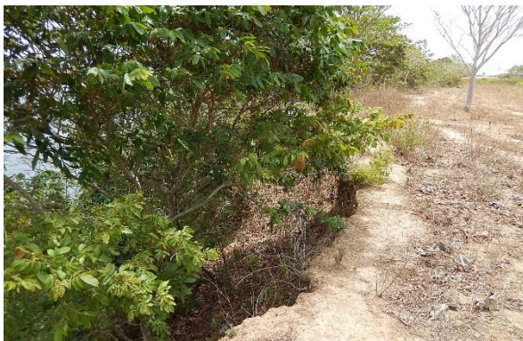
Foto 29-Perfil longitudinal do talude.
