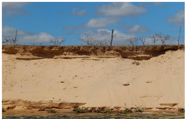
Foto 68 - Detalhe do solapamento da base do talude.
