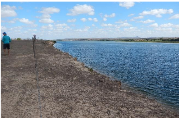
Foto 67 - Vista do topo do talude em direção ao rio.
