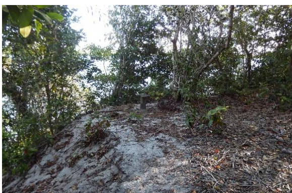
Foto 46 - Feição erosiva existente no local.
