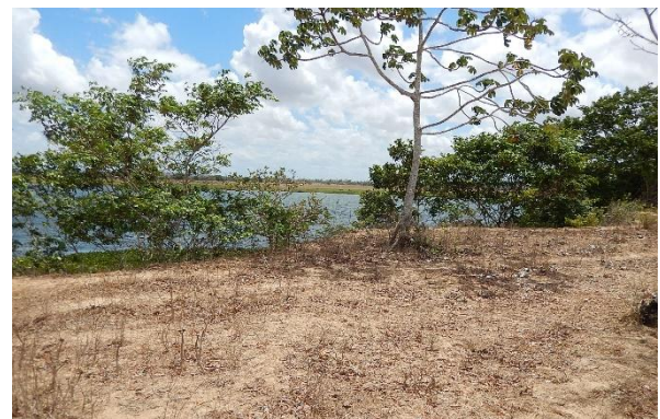
Foto 30-Vista superior do talude.
