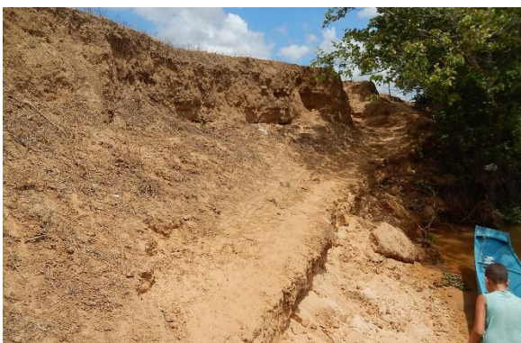
Foto 37 - Vista longitudinal da superfície do talude.
