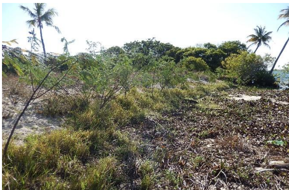
Foto 50 - Vista longitudinal do talude.
