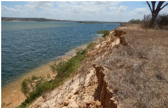
Foto 76 - Perfil longitudinal do topo do talude.
