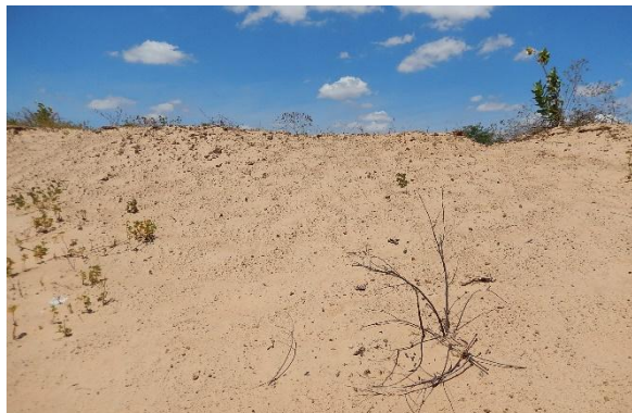
Foto 57 - Vista frontal do talude.
