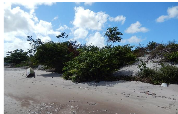
Foto 42 - Perfil transversal da base do talude.
