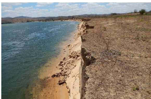
Foto 60 - Perfil do talude monitorado.
