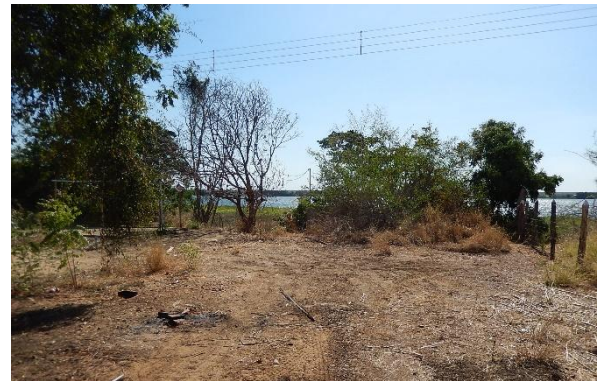
Foto 16- Vista superior do talude em direção ao rio.
