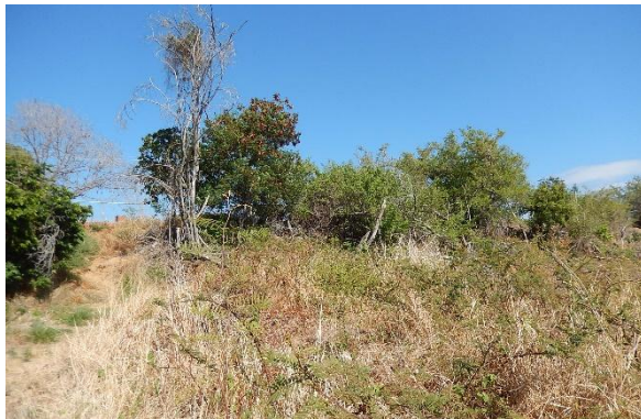
Foto 15 - Detalhe da porção frontal do talude.
