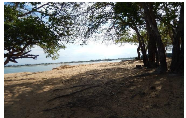
Foto 6- Vista geral da porção superior do talude com indivíduos arbóreos isolados.
