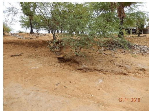
Foto 10-Perfil transversal da base do talude.
