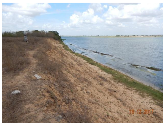
Foto 23 - Perfil longitudinal do talude.
