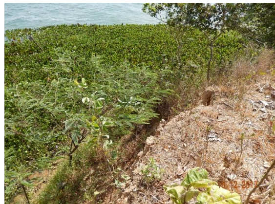
Foto 29 - Vista superior do talude.
