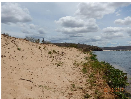
Foto 54 - Perfil longitudinal do talude monitorado.
