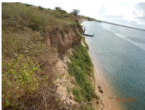
Foto 70 - Perfil longitudinal das paredes do talude.
