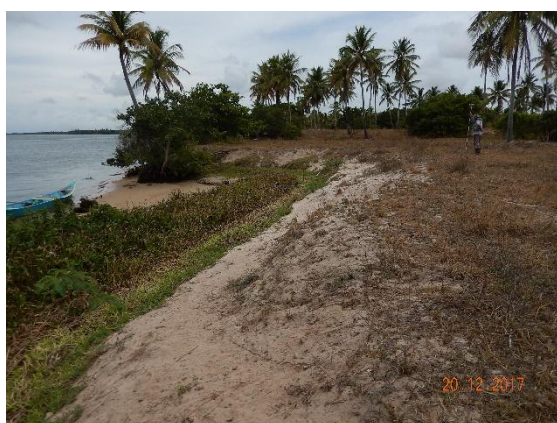
Foto 49 - Vista longitudinal do talude.
