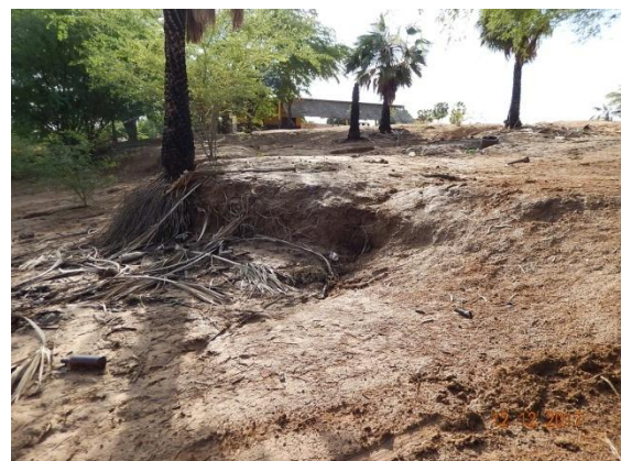
Foto 10 - Perfil transversal da base do talude.
