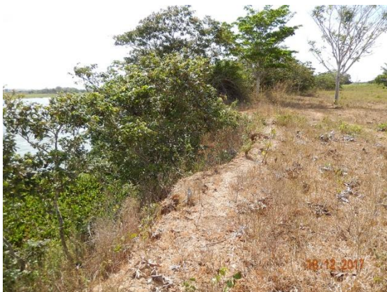
Foto 28 - Perfil longitudinal do talude.
