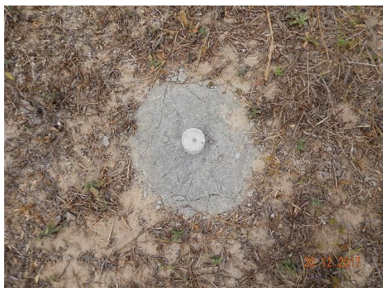
Foto 47 - Detalhe do marco topográfico M-01.
