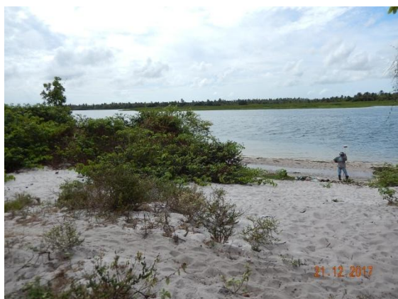
Foto 40 - Vista superior do talude.
