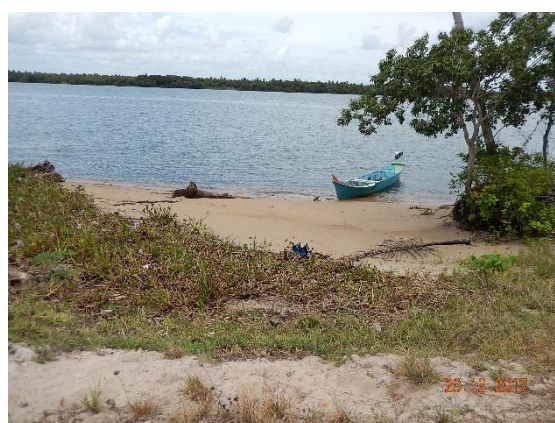
Foto 50 - Vista do topo do talude em direção ao rio.
