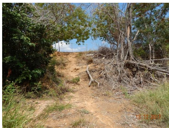
Foto 14 - Detalhe da porção frontal do talude.
