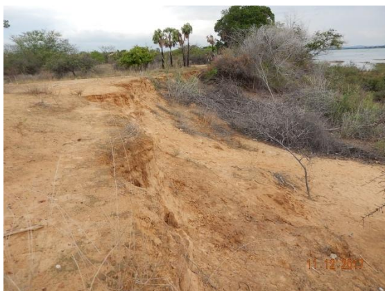
Foto 5 - Vista longitudinal da parte superior do talude.
