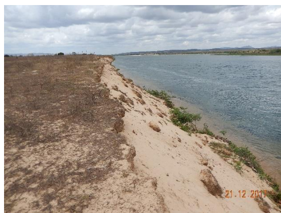
Foto 65 - Perfil longitudinal do talude.
