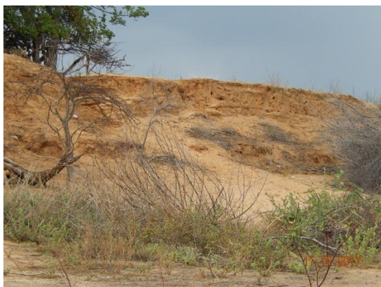
Foto 3 - Vista frontal do talude exposto.
