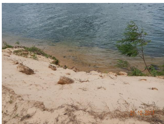
Foto 66 - Vista do topo do talude em direção ao rio.
