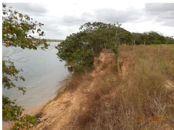
Foto 36 - Vista longitudinal da superfície do talude.
