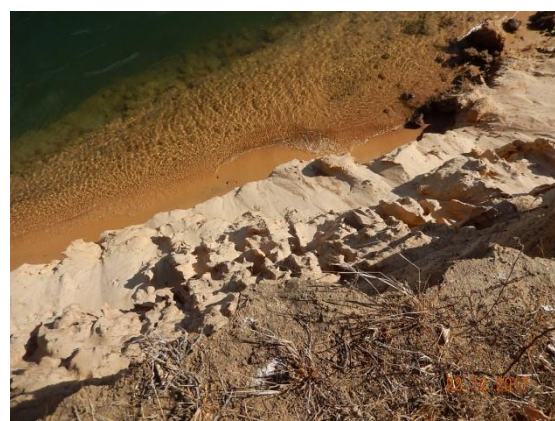
Foto 60 - Vista superior do talude.
