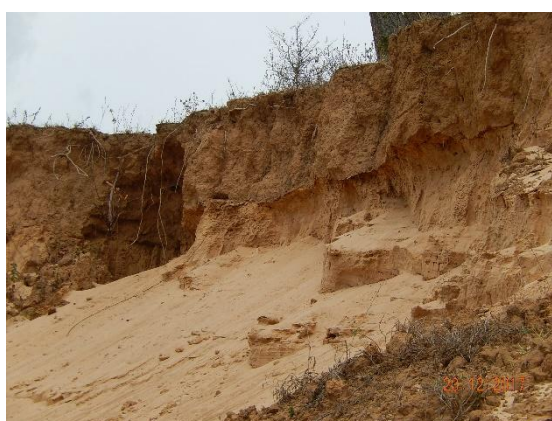
Foto 77 - Detalhe do solapamento de topo do talude.
