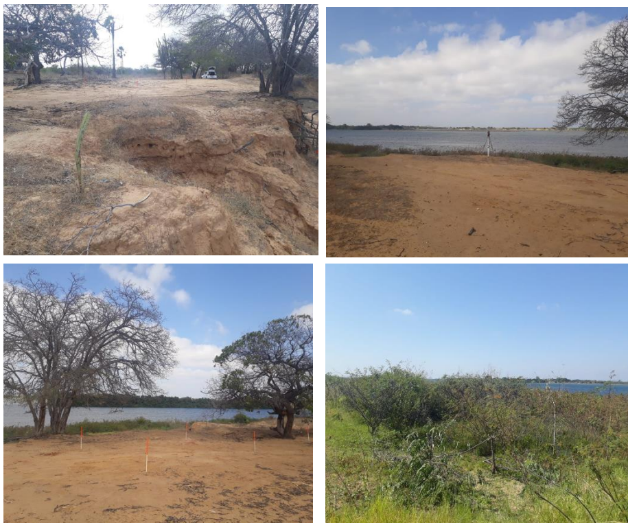
Figura 13 – Estação EM 1.1 com visão do coroamento barranco e nível do rio ocupado com vegetação arbustiva.
