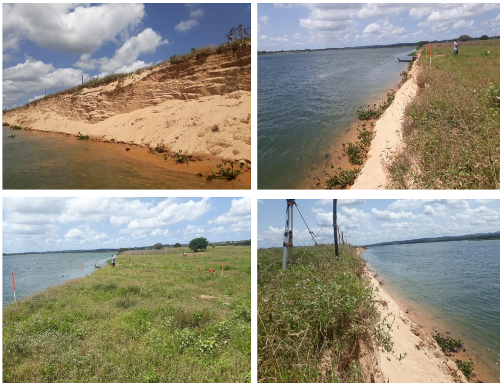
Figura 33 – Monitoramento Fotográfico da EM B-08. Talude destituído de vegetação ao nível d'água em solo arenoso
