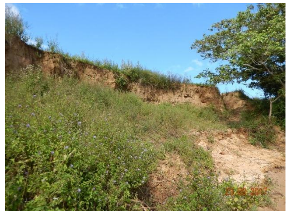
Foto 35 - Detalhe da porção frontal do talude monitorado.
