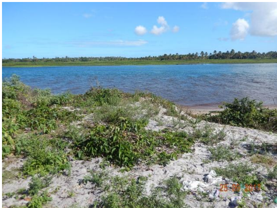
Foto 40 - Vista superior do talude.
