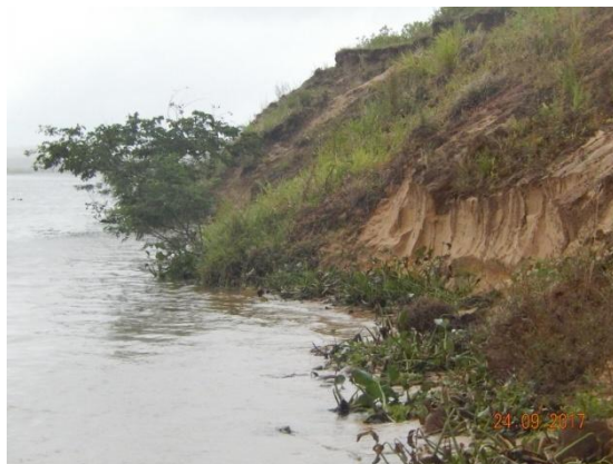
Foto 77 - Solapamento da base do talude em função da ação das ondas.
