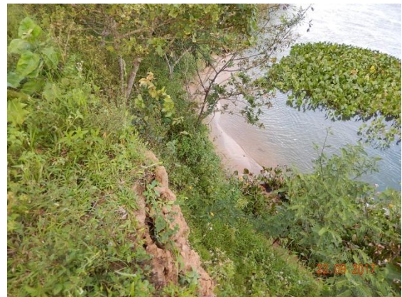
Foto 29 - Vista superior do talude.
