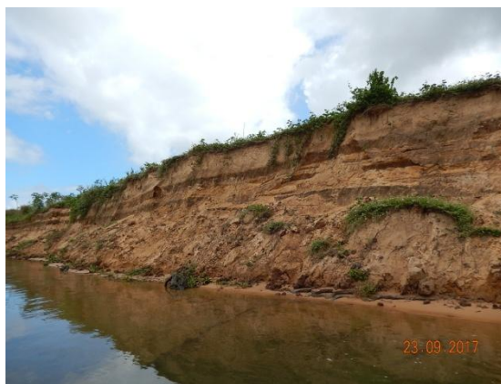
Foto 72 - Vista geral da frente do talude erodido.
