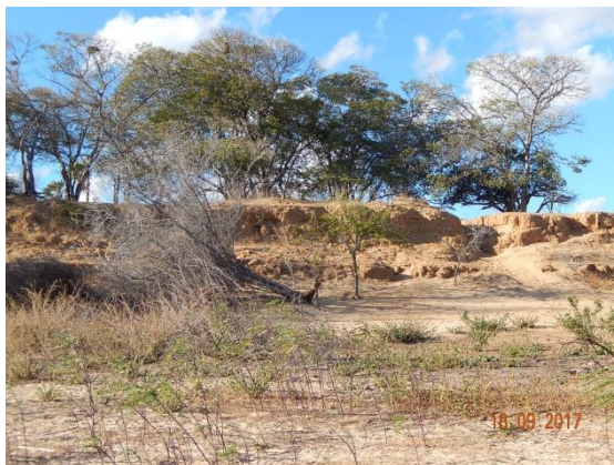
Foto 3 - Vista frontal do talude exposto.
