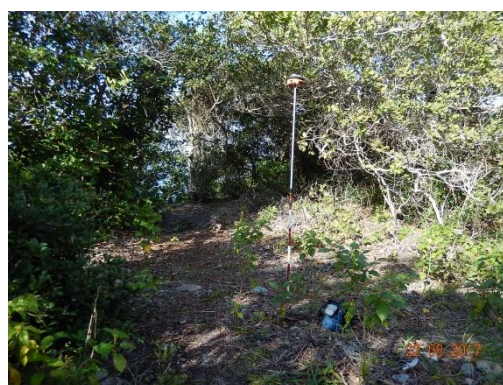
Foto 46 - Mapeamento realizado na porção superior do talude.
