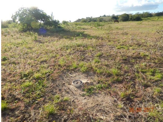
Foto 52 - Vista geral do topo do talude com o marco topográfico M-01.
