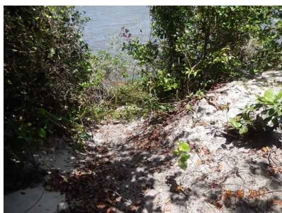
Foto 45 - Feição erosiva existente no local.
