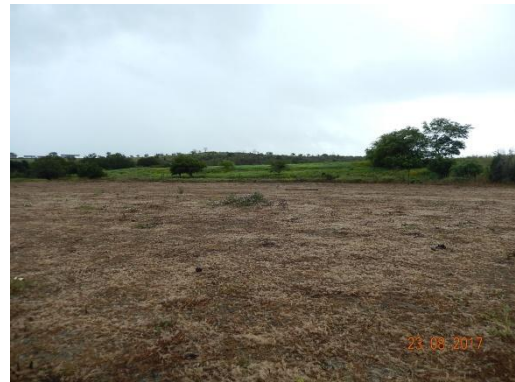
Foto 55 - Processo de solapamento da base do talude causado pela ação das ondas no processo de erosão fluvial.
