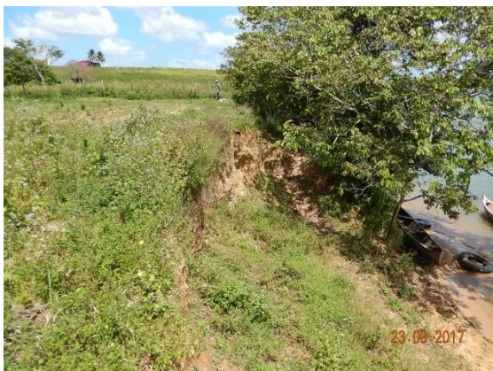
Foto 36 - Vista longitudinal da superfície do talude.
