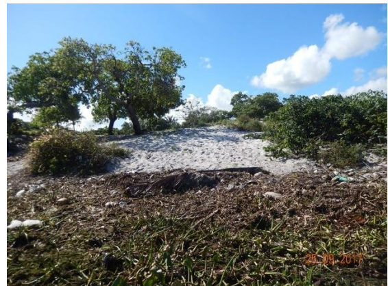
Foto 41 - Perfil frontal do talude.
