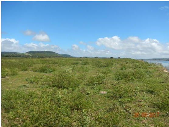
Foto 64 - Vista geral da parte superior do talude.
