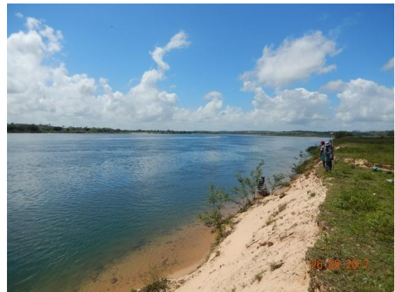
Foto 65 - Perfil longitudinal do talude.
