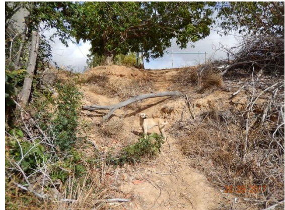
Foto 14 - Detalhe da porção frontal do talude.
