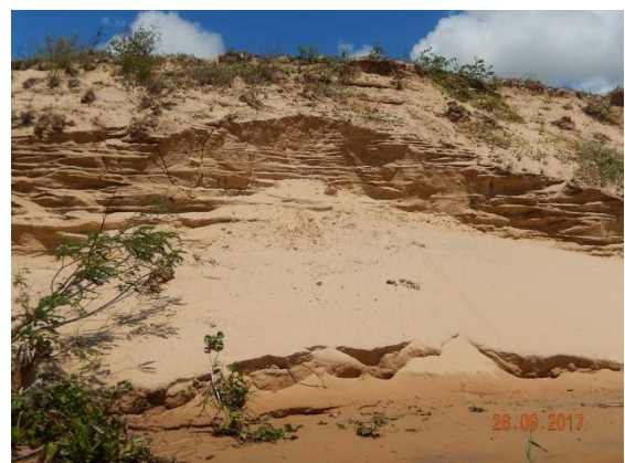
Foto 67 - Detalhe do solapamento da base do talude.
