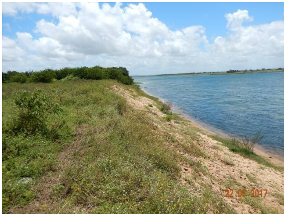
Foto 23 - Perfil longitudinal do talude.
