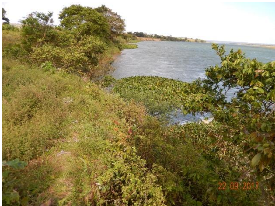
Foto 28 - Perfil longitudinal do talude.
