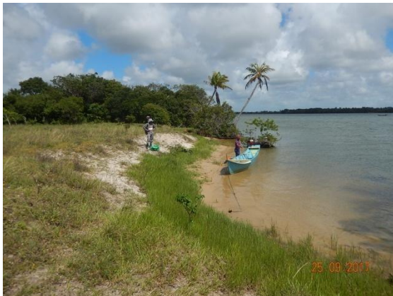
Foto 49 - Vista longitudinal do talude.
