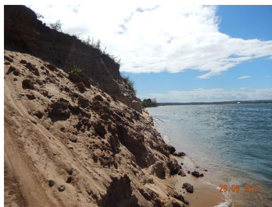
Foto 61 - Detalhe do intenso processo erosivo e acentuada inclinação do talude.
