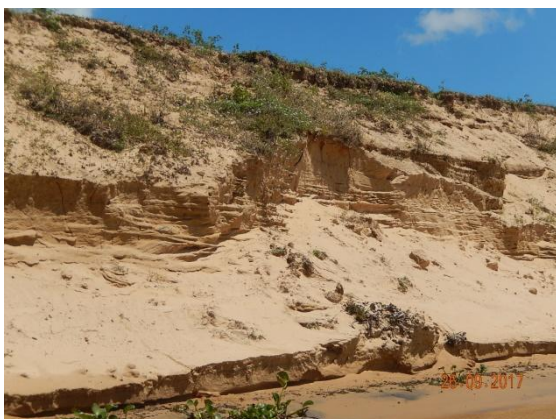
Foto 66 - Vista geral do intenso processo erosivo que ocorre na base do talude devido a ação das ondas.
