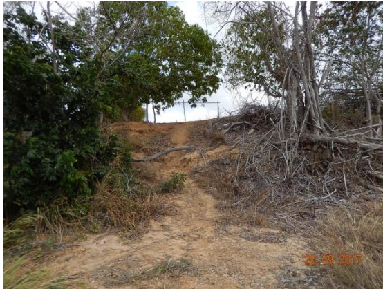
Foto 13 - Vista geral do talude.
