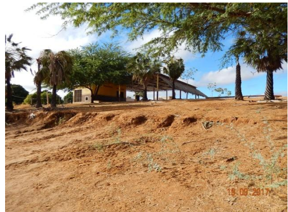
Foto 10 - Perfil transversal da base do talude.
