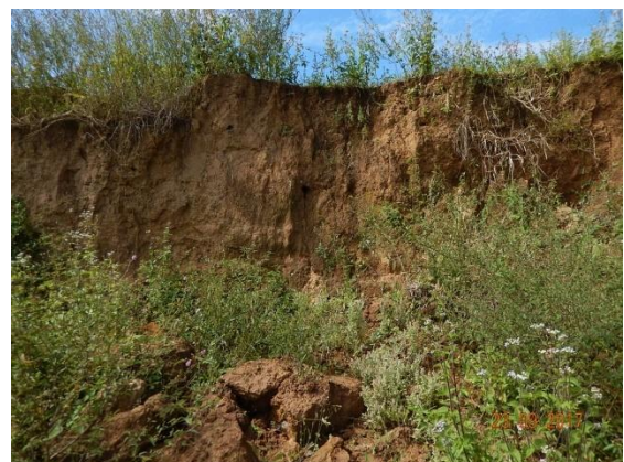
Foto 37 - Detalhe da porção frontal do talude erodida.
