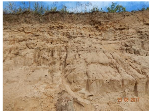
Foto 60 - Vista frontal do talude com destaque para o ativo desmoronamento da crista.
