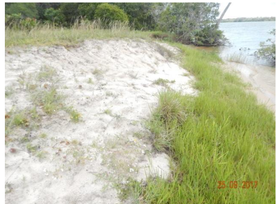
Foto 50 - Detalhe do talude erodido.
