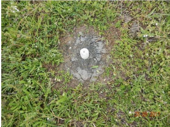
Foto 47 - Detalhe do marco topográfico M-01.
