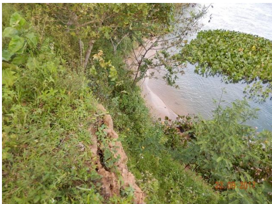
Foto 30 - Detalhe da elevada inclinação do talude e exposição do solo.
