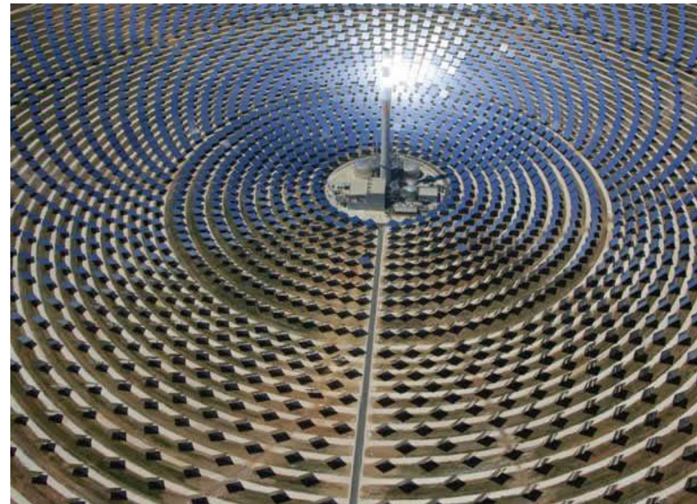
HELIOTÉRMICATORRE CENTRAL Potência Nominal: 250 kWe Tecnologia: Torre Central Armazenamento Térmico: 4 h Área dos Espelhos: 6.000 m 2 Investimento: R$ 62,3 Milhões
