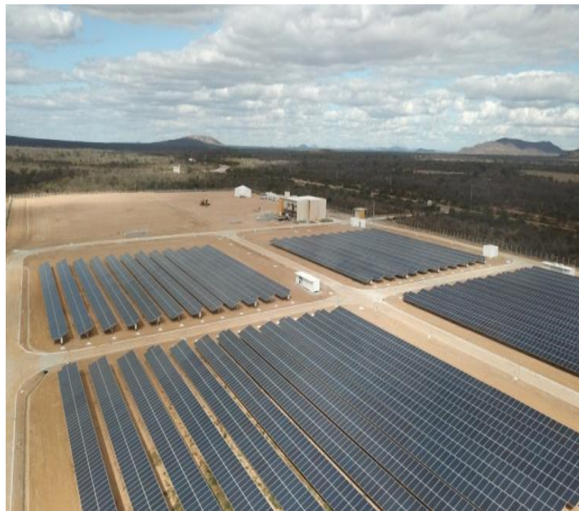
USINA FOTOVOLTÁICA Potência Nominal: 2,5 MW
