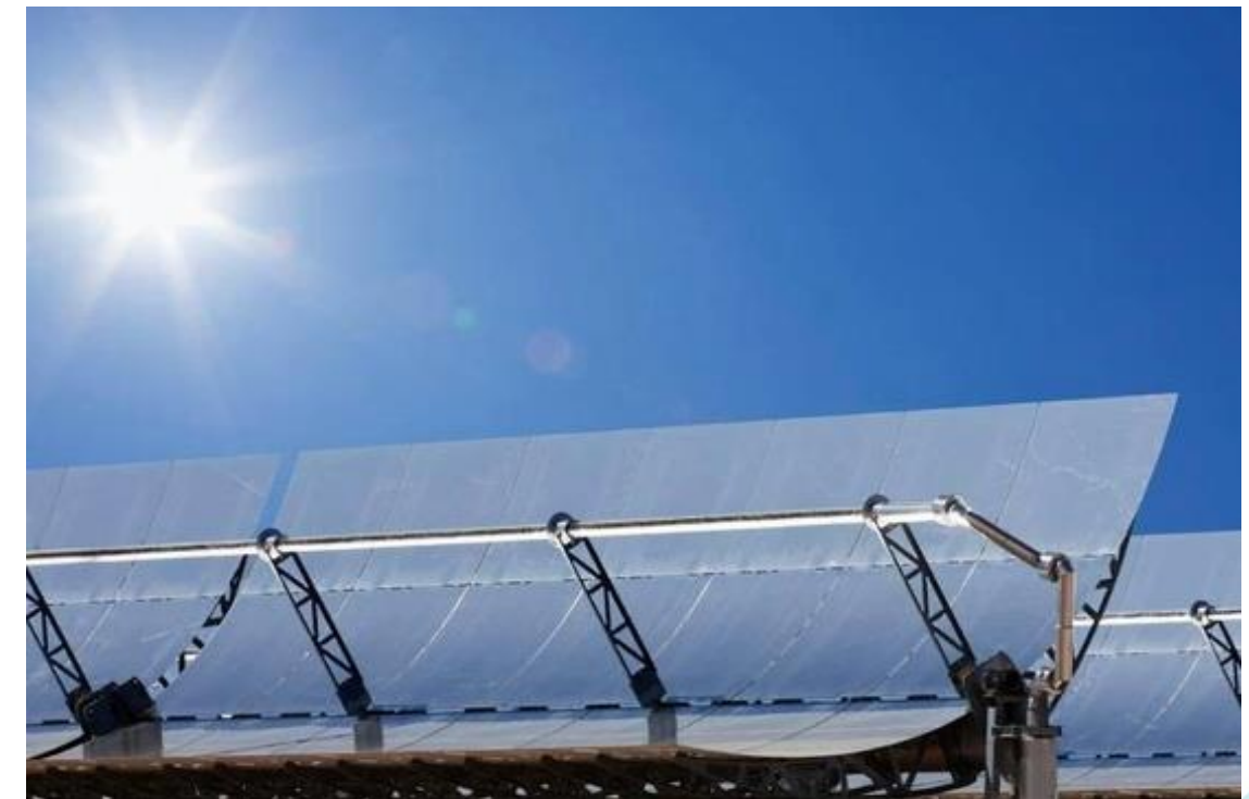
HELIOTÉRMICA CALHA PARABÓLICA Potência Nominal: 1 MWe Tecnologia: Calha Parabólica Produção Anual de Energia Líquida (estimada): 1.967 MWh Área dos Espelhos: 9.936 m 2 Investimento: R$ 67,9 Milhões
