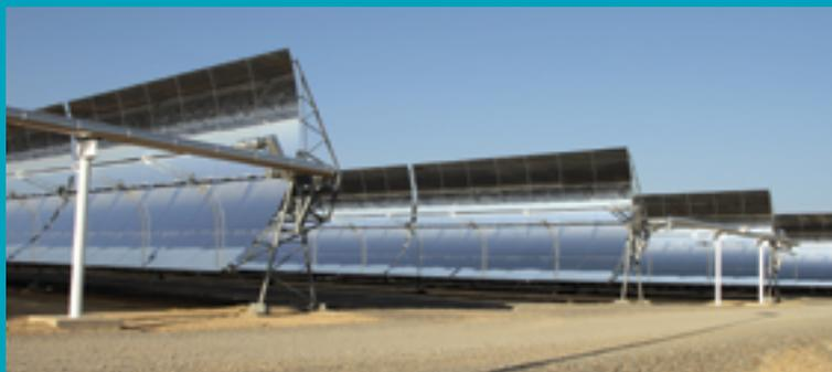
Os coletores cilíndricos parabólicos são revestidos por um material refletor. Quando a parábola aponta para o sol, os raios diretos são refletidos pela superfície e concentrados no receptor. A radiação concentrada aquece o fluido que circula internamente no tubo absorvedor.
