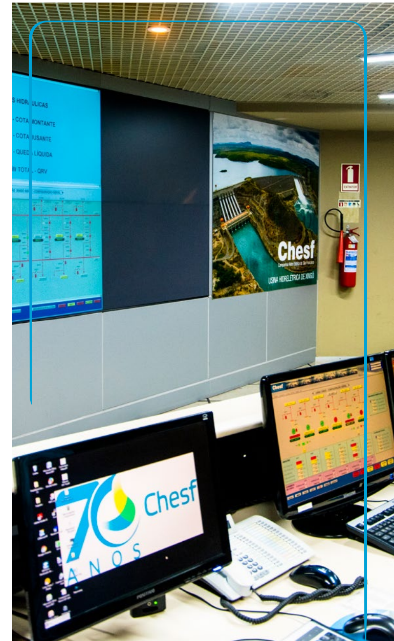
Sala de comando da usina de Xingó, em Sergipe. Crédito: André Schuler.
