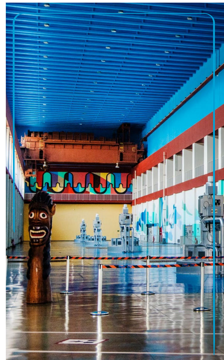
Usina Hidrelétrica Apolônio Sales. Crédito: Andre Schuler/Chesf.
