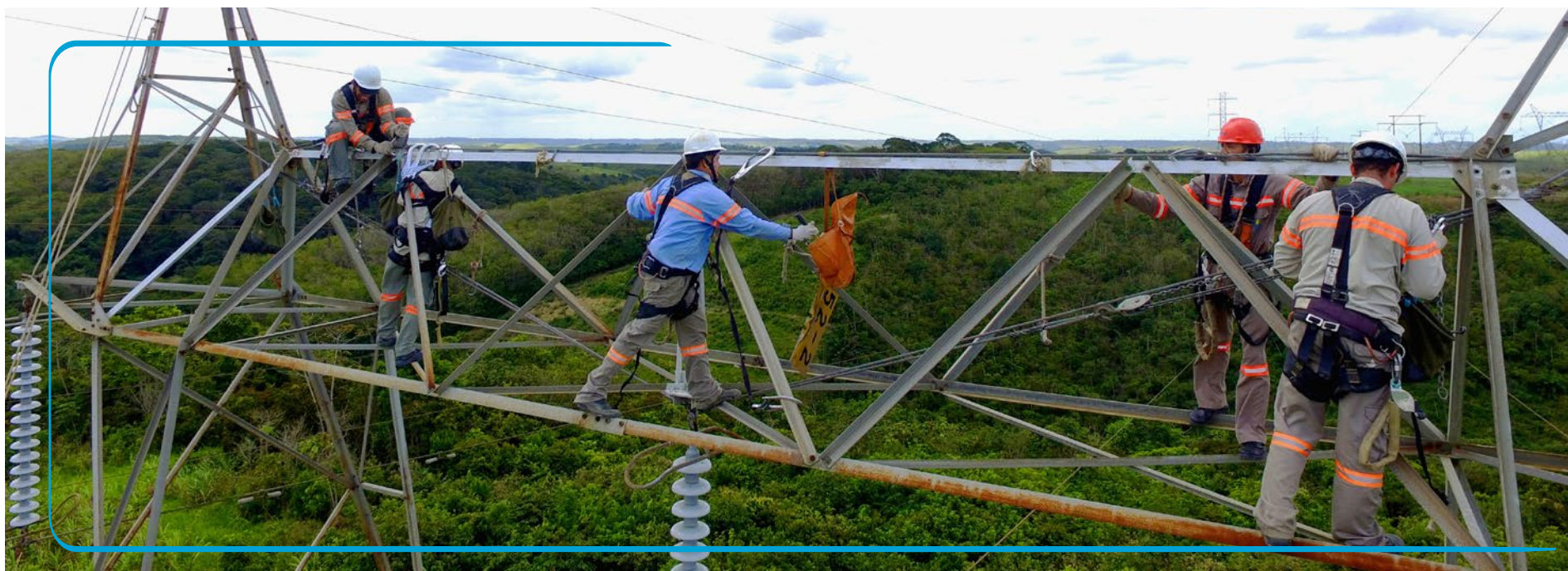
Manutenção em linhas de transmissão. Crédito: Eduardo Vilaça.
