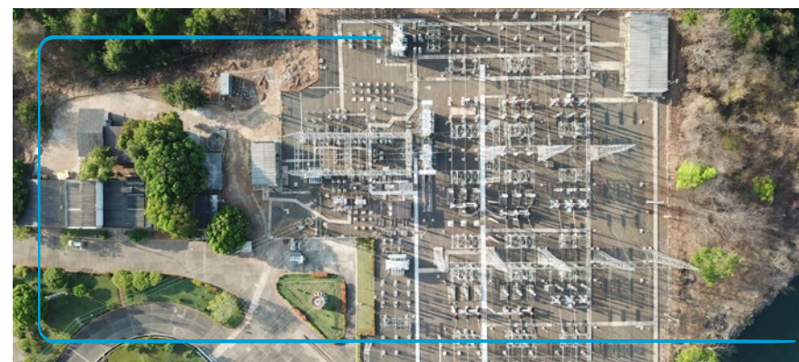
Subestação Boa Esperança, no Piauí. Crédito: Drone Sudene.
