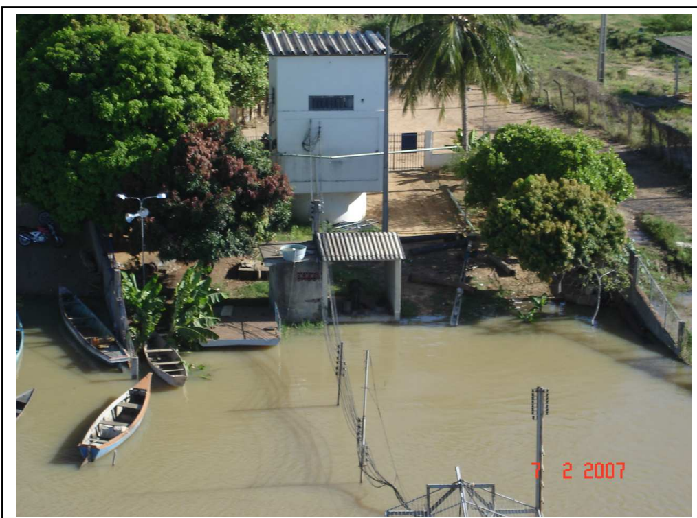
Foto 08 – Situação da captação fixa do SAAE no dia 07/02/2007, com vazão média diária de 5.518 m 3 /s, registrada pelo posto hidrométrico de Juazeiro - BA.
