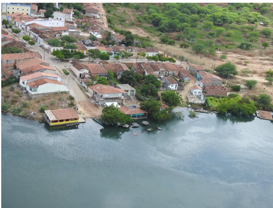
03/02/2022 → Q = 4.000\text{m}^3/\text{s} – Povoado Alecrim/AL, montante de Belo Monte. Estruturas de lazer próximas ao cais.
