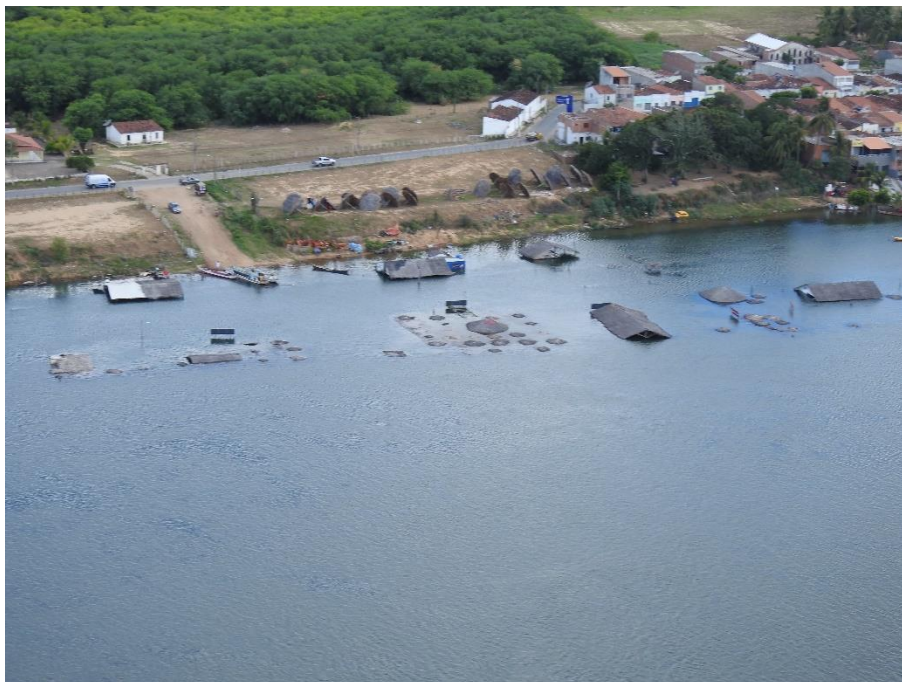
21/01/2022 → Q = 3.000 \text{ m}^3/\text{s} – Pão de Açúcar/AL – Estruturas recreacionais a montante da cidade.
