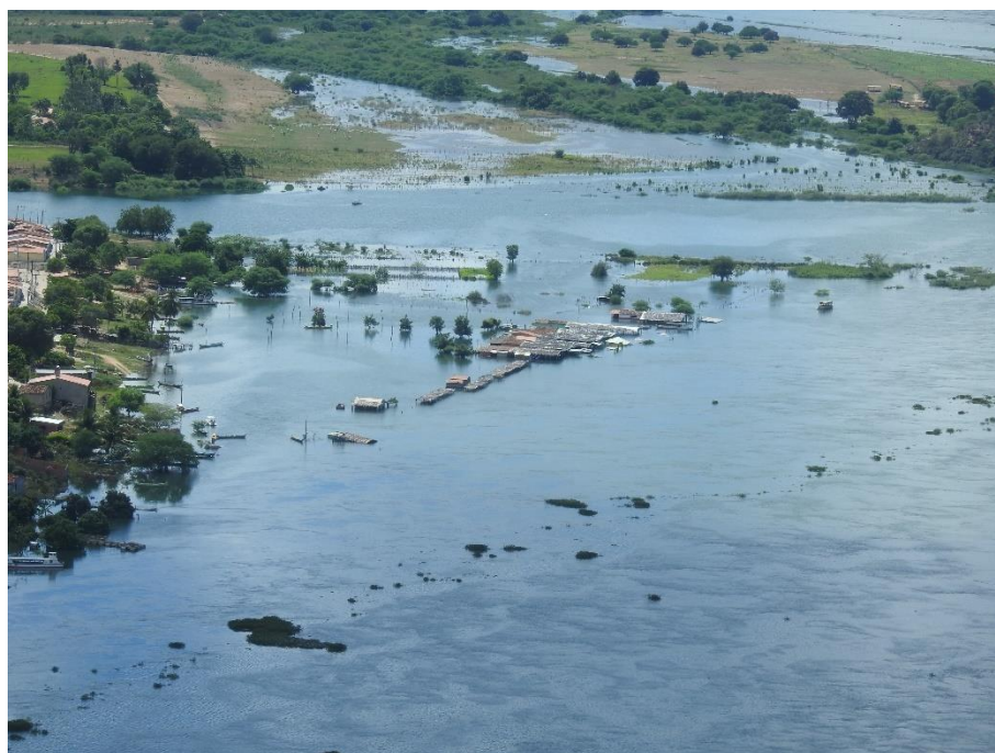
21/01/2022 → Q = 3.000 \text{ m}^3/\text{s} – Povoado Barra do Ipanema (Foz do Rio Ipanema), município de Belo Monte/AL. Estruturas recreacionais.
